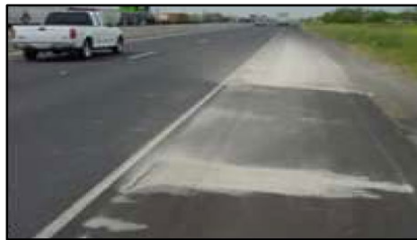
Figura 18: Afloramiento de mortero
