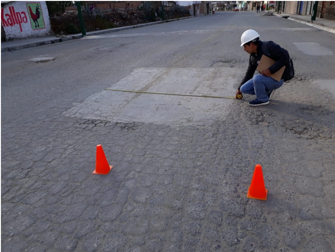
Fotografía 1: Se aprecia en la imagen la medida de parcheo realizado en el pavimento.
