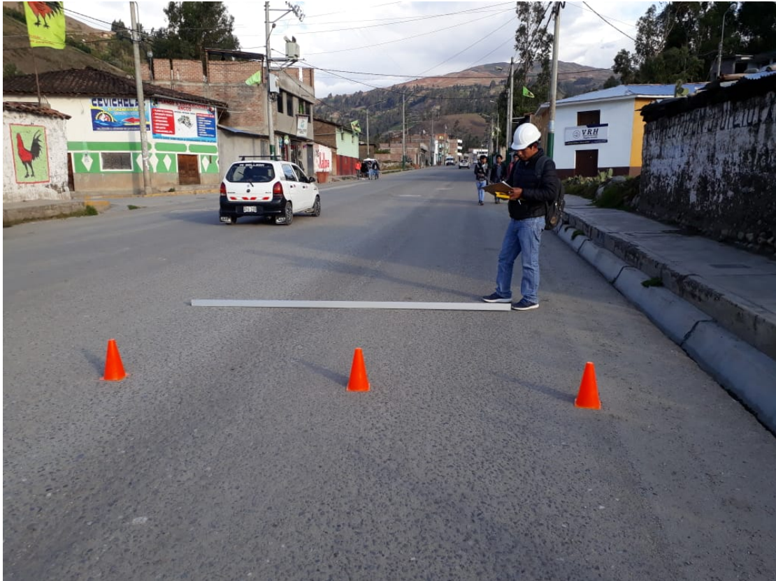
Fotografía 3: Se observa el registro en campo de las fallas del pavimento.
