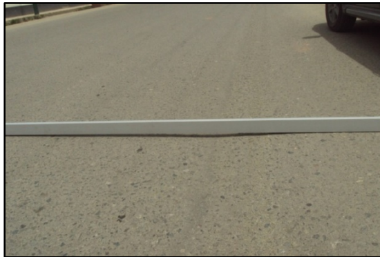
Figura 2: Ahuellamiento
