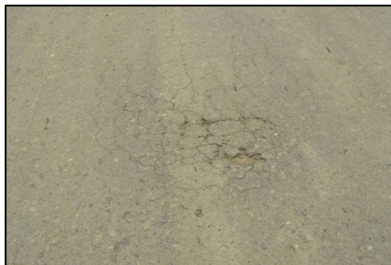
Figura 9: Fisuras parabólicas
