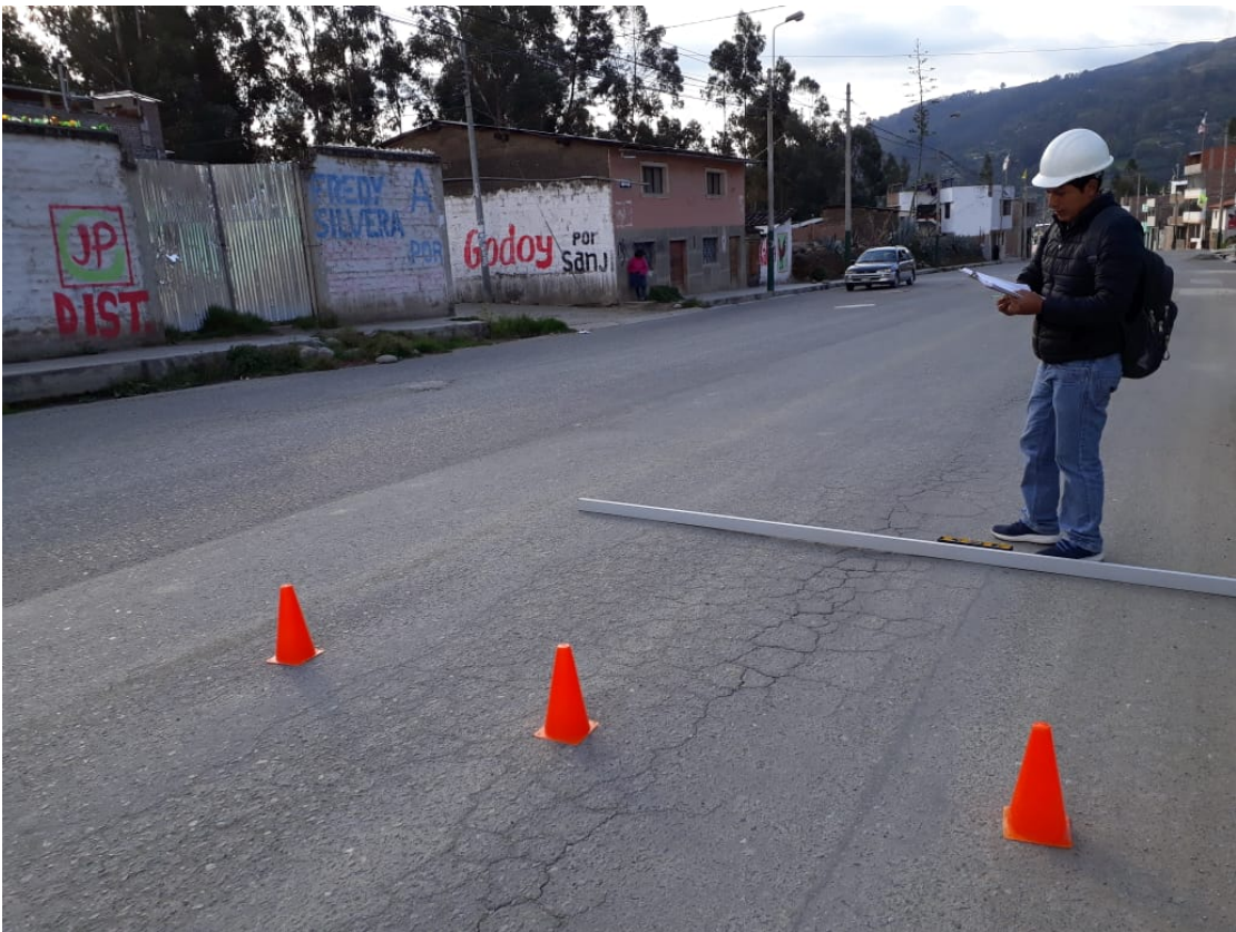
Fotografía 6: Se observa en la imagen el registro de la falla.
