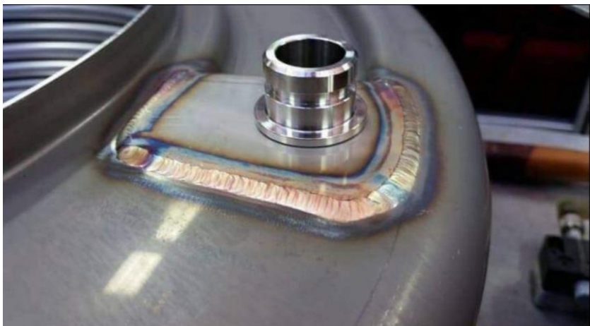
Figura 8. Parche de Adaptador para Ingreso de líquido en Tanque de Ácido sulfúrico.
