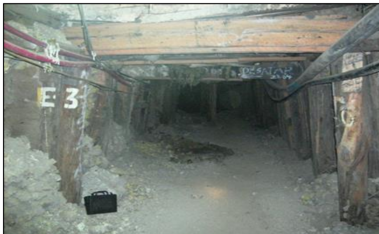
Figura 9. Sostenimiento con cuadros de madera Fuente: Manual de Geomecánica- DCR Ingenieros S.R.Ltda.
