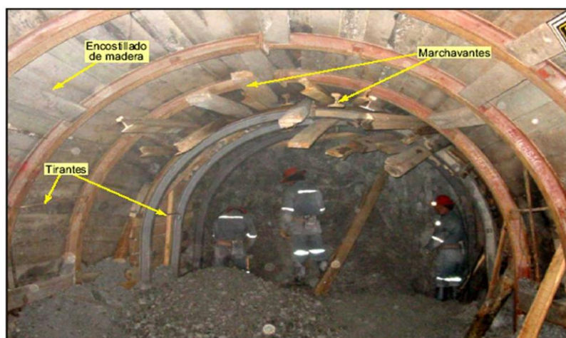
Figura 10. Sostenimiento con Cimbras Fuente. Manual de Geomecánica- DCR Ingenieros S.R. Ltda.
