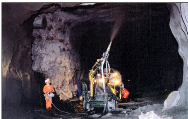
Figura 11. Sostenimiento con lanzado de Shocrete. Fuente. Imagen extraída de internet.
