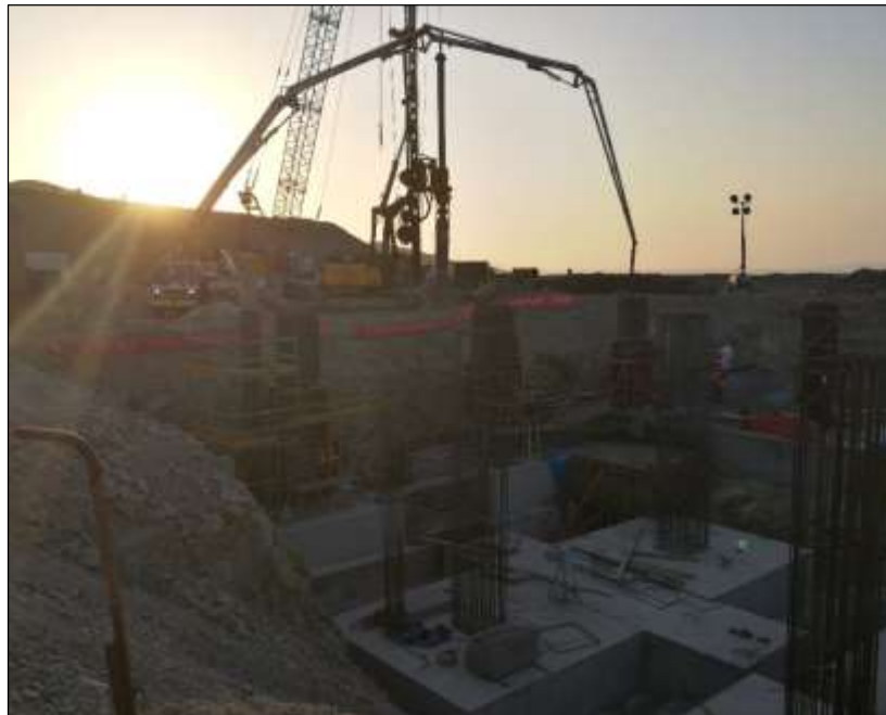
Figura 5.32. Vaciado de la Zapata del Área 3: Taller de filtración
