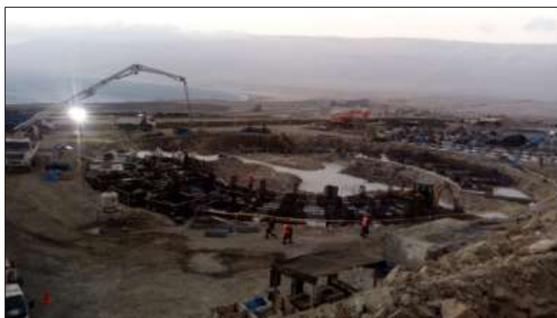
Figura 5.31. Vaciado del área 1:Espesadores de concentrados
