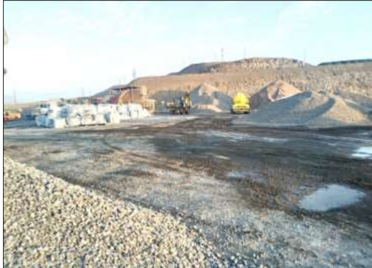
Figura 5.29. Área de agregados, cemento, cisterna y planta de concreto
