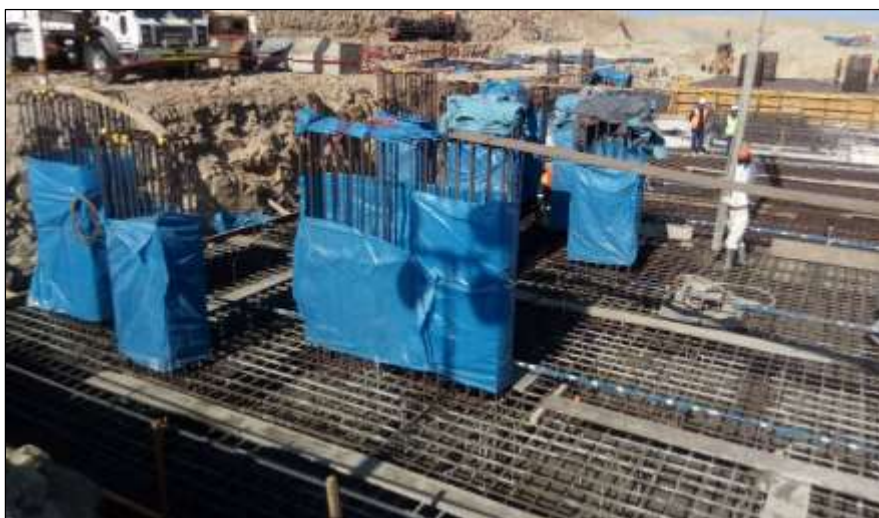
Figura 5.33. Vaciado de cimentación PF5: zarandas
