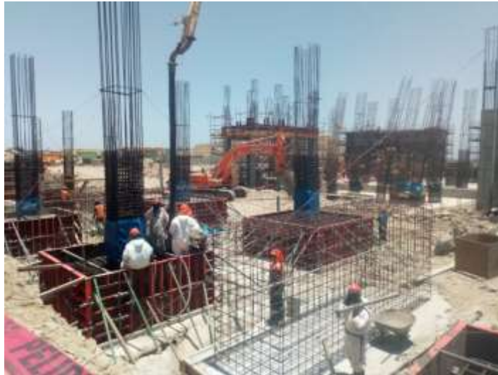
Figura 5.3. Vaciado de Zapata en el área 2: 5772 Taller de Filtración
