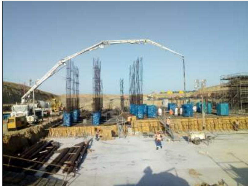
Figura 5.34. Vaciado de Cimentación PF3: 1era etapa zarandas
