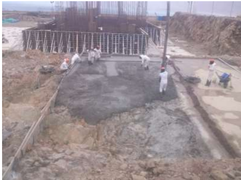
Figura 5.4. Vaciado de solado en el área 3: 5730 Taller de Tamización (2017)
