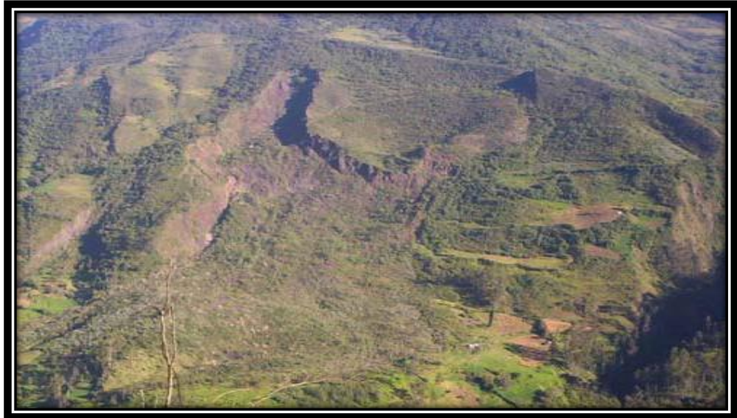
Figura 11: Vista panorámica del deslizamiento Cocha Pumaranra ubicado en la margen derecha del río Colcaqui, afluente del río Mariño (extraído de Fernández et al., 2007).
