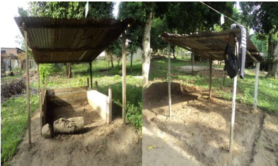
Figura N° 05: Adecuación del terreno y construcción de las composteras. Fuente: Elaboración propia 2013.
