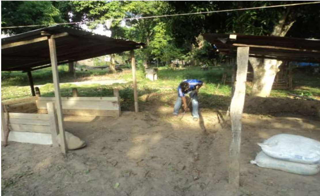
Figura N° 06: Adecuación del terreno y construcción de las composteras. Fuente: Elaboración propia 2013.
