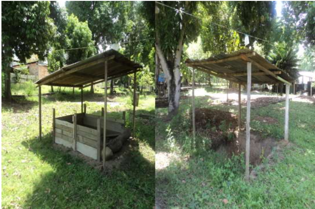
Figura N° 04: Adecuación del terreno y construcción de las composteras. Fuente: Elaboración propia 2013.
