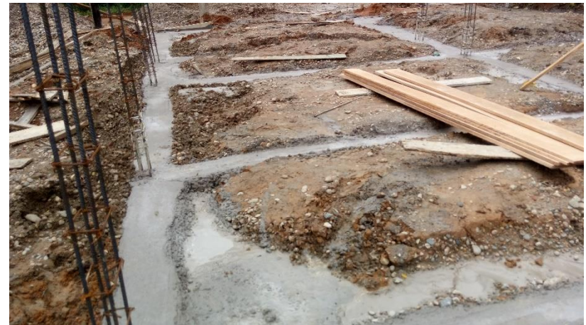
Proceso de construcción: Etapa 2
