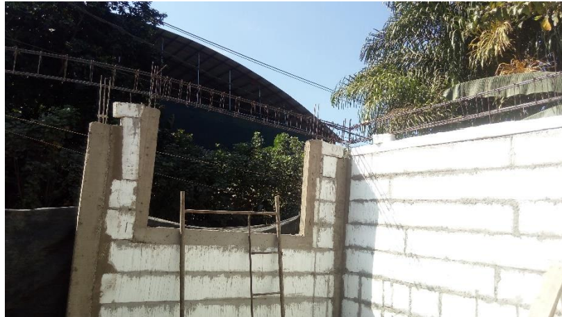
Proceso de construcción: Etapa 7
