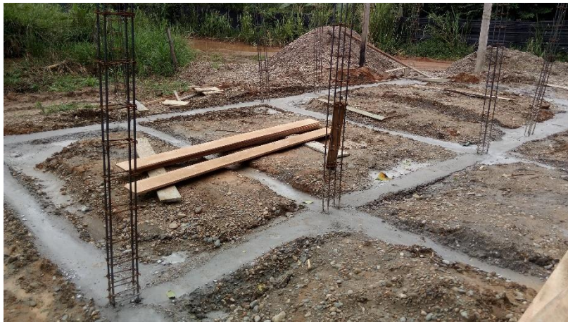
Proceso de construcción: Etapa 2
