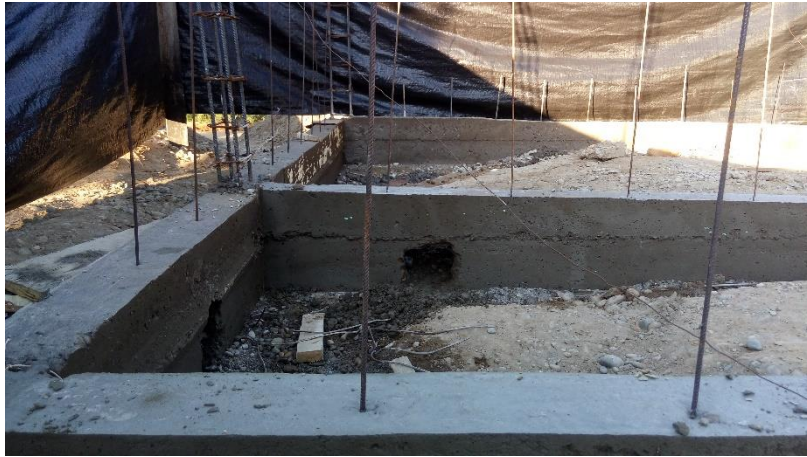
Proceso de construcción: Etapa 3
