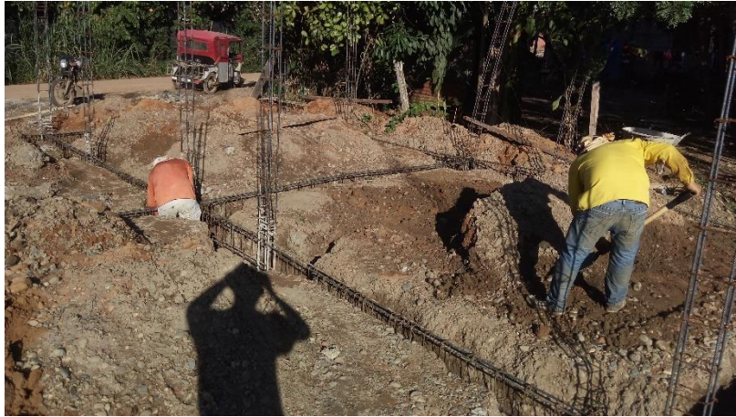
Proceso de construcción: Etapa 1
