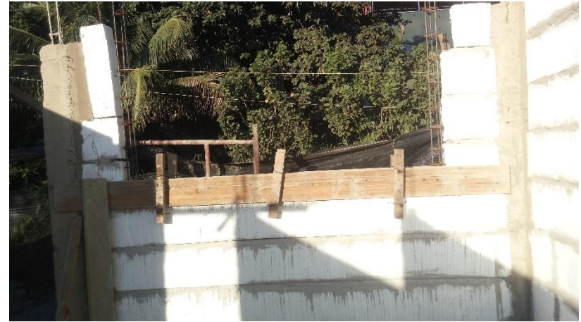
Proceso de construcción: Etapa 6
