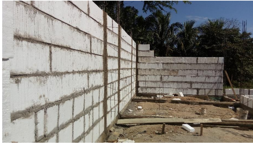
Proceso de construcción: Etapa 5
