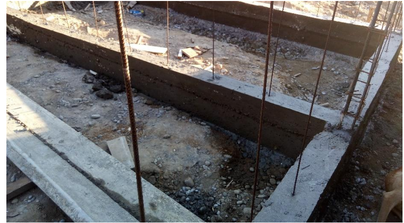
Proceso de construcción: Etapa 3
