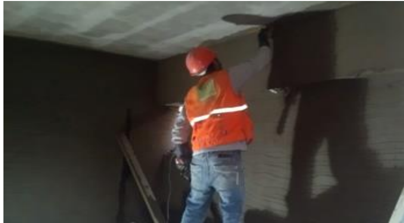
Proceso de construcción: Etapa 8
