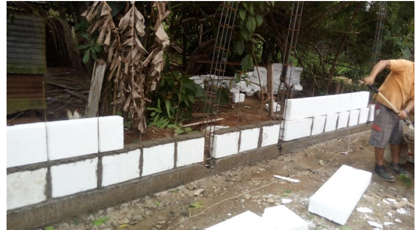
Proceso de construcción: Etapa 4
