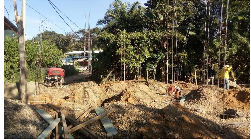
Proceso de construcción: Etapa 1
