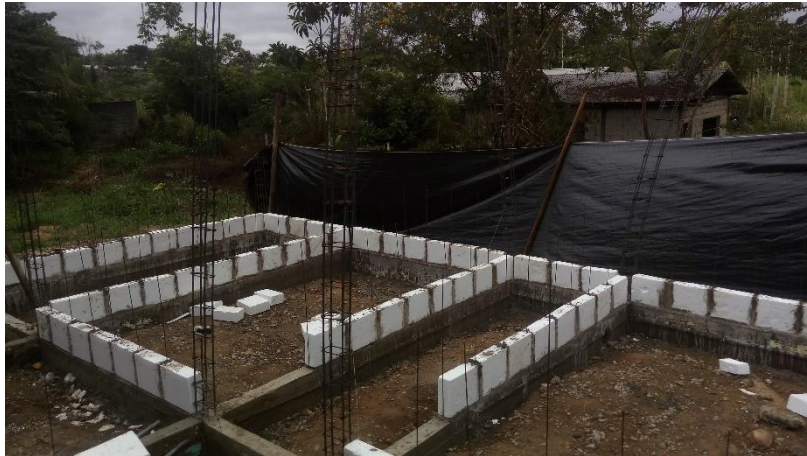
Proceso de construcción: Etapa 4
