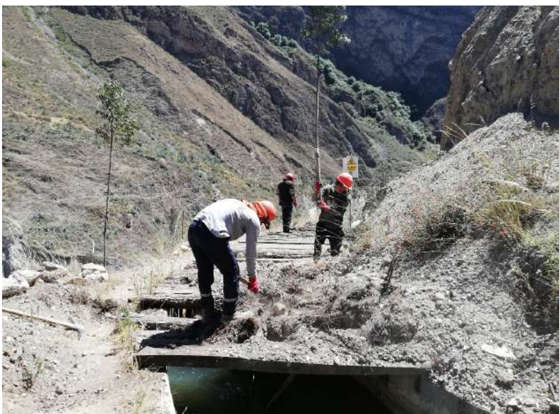
Figura n° 13: Limpieza de desmonte sobre las vigas de madera
