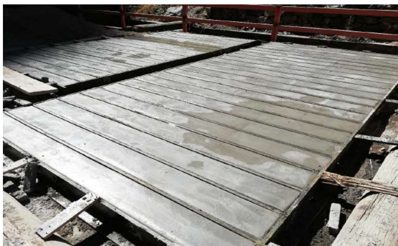
Figura n° 22: Curado de Vigas prefabricadas.
