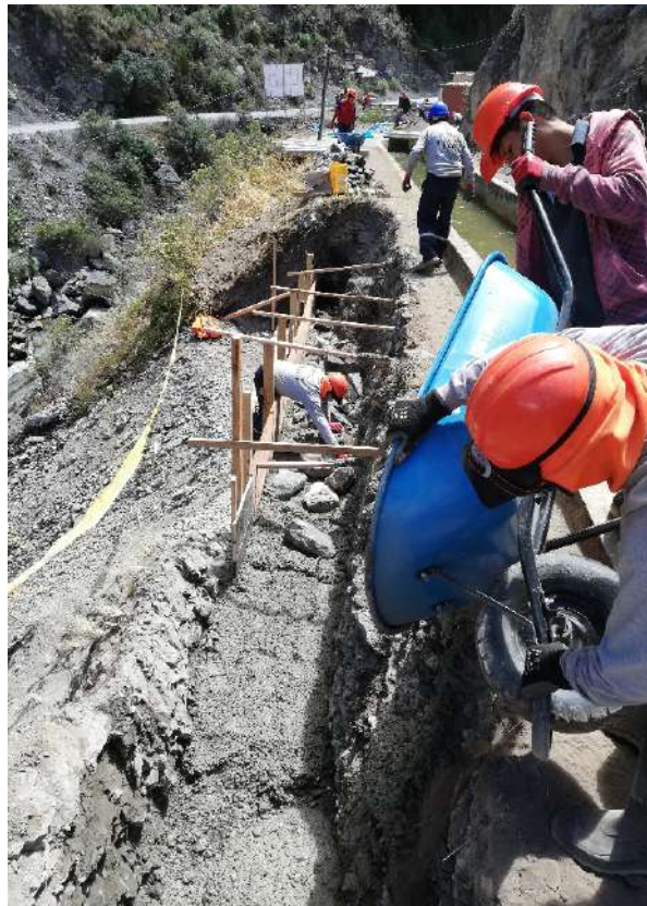
Figura n° 25: Culminación de llenado de concreto de muro de contención.
