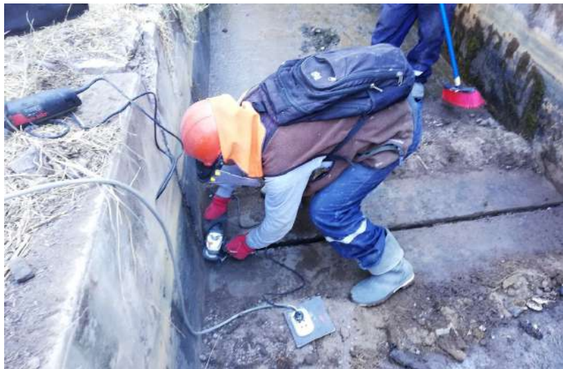
Figura n° 40: Limpieza de la junta de dilatación con disco.
