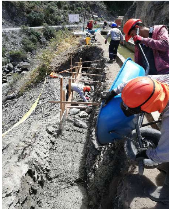
Figura n° 18: Llenado de concreto de muro de contención.
