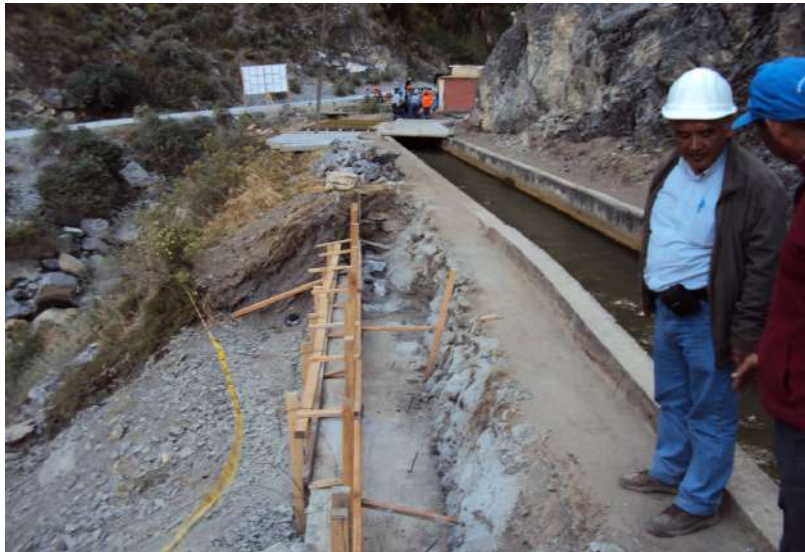
Figura n° 17: Encofrado de muro de contención.
