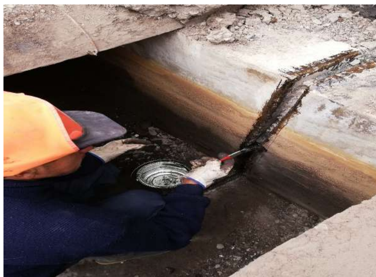
Figura n° 42: Colocación de aditivo en las paredes de las juntas.
