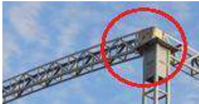
Imagen 19 Viga Principal "Tijeral T-2"
