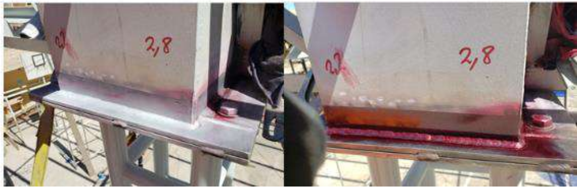
Imagen 69 Ensayo de Líquidos Penetrantes
