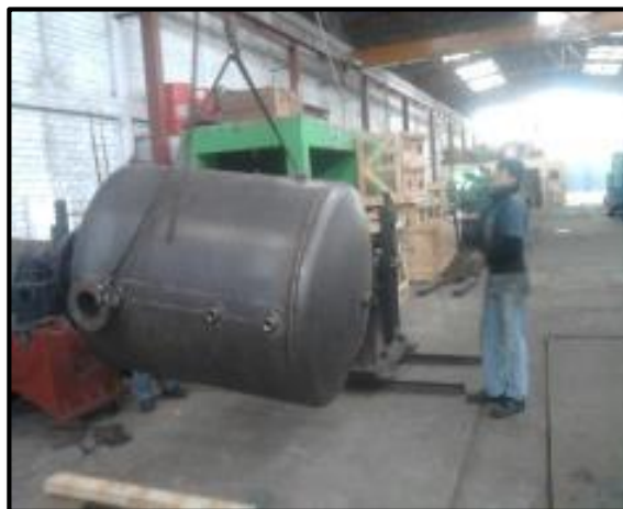
Figura 5: PROCESO DE ARMADO DE ESTRUCTURAS METÁLICAS
