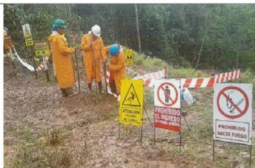
Imagen 06: KP 8+900, Vista de los trabajos de señalización del área del evento. (03.02.2018)
