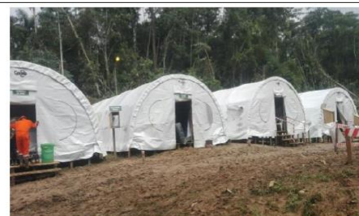
Imagen 07: KP 8+350, Construcción de campamento provisional para el personal que trabajó en la reparación del ducto de LGN.
