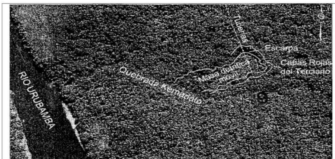
Imagen 01: Vista panorámica de la zona donde se detectó incidente de falla en el ducto de transporte de líquidos de gas natural.
