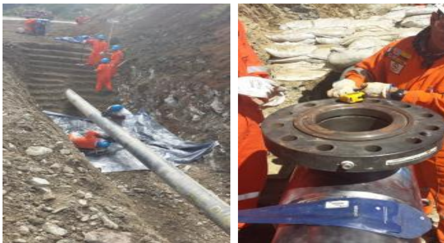
Figura 4 Split Tee Instalado en Tubería de Gas
