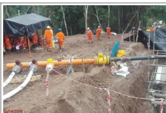
Imagen 23: KP 9+170, Vista de trabajos de instalación del spool, manifold, válvulas y tuberías flexibles. (14.02.2018)
