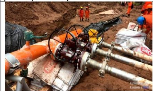
Imagen 25: Vista general de la derivación, lado Malvinas, del bypass instalado. (15.02.2018)
