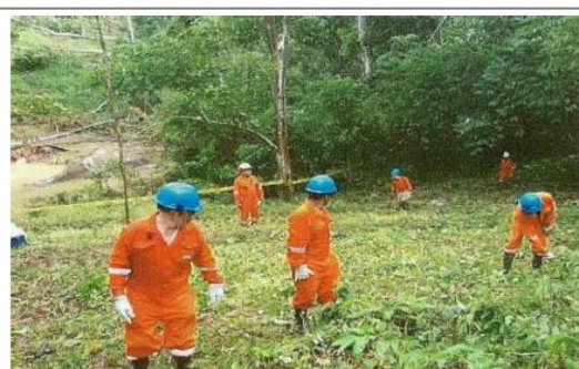
Imagen 05: KP 8+900, Vista de los trabajos de delimitación del área del evento. (03.02.2018)
