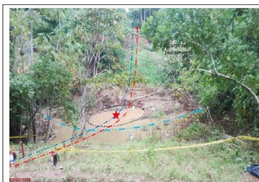
Imagen 03: KP 8+900, Vista de zona de la rotura de la tubería de LGN, con burbujeo de vapores de LGN. (07.02.2018)
