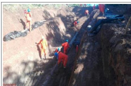
Imagen 22: Vista de las actividades de excavación de tubería de 14" en dirección a Malvinas. (10.02.2018)
