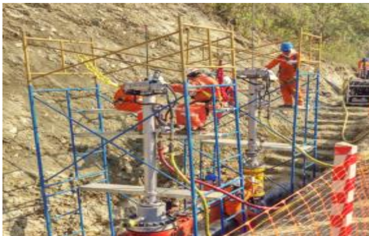
Figura 6 Perforación del ducto
