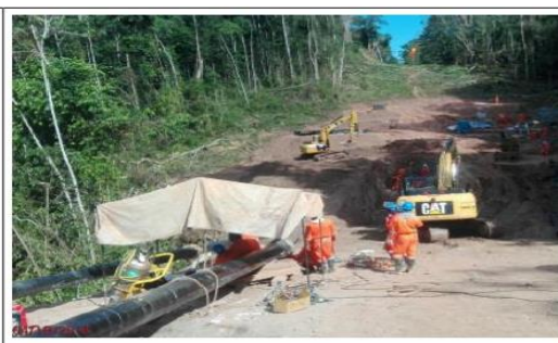
Imagen 27: KP 8+900, Vista de los trabajos de construcción del bypass de 14" para transporte de LGN.
