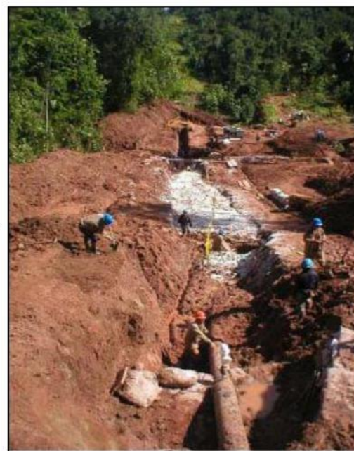
Imagen 07, 08 y 09: Trabajos de reparación del ducto fallado.
