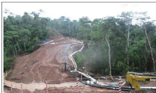
Imagen 26: KP 8+900, vista de las líneas de bypass de GN, con tubería rígida de 14".
