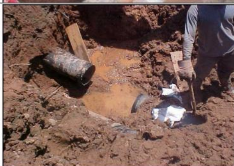
Imagen 07, 08 y 09: Trabajos de reparación del ducto fallado.
