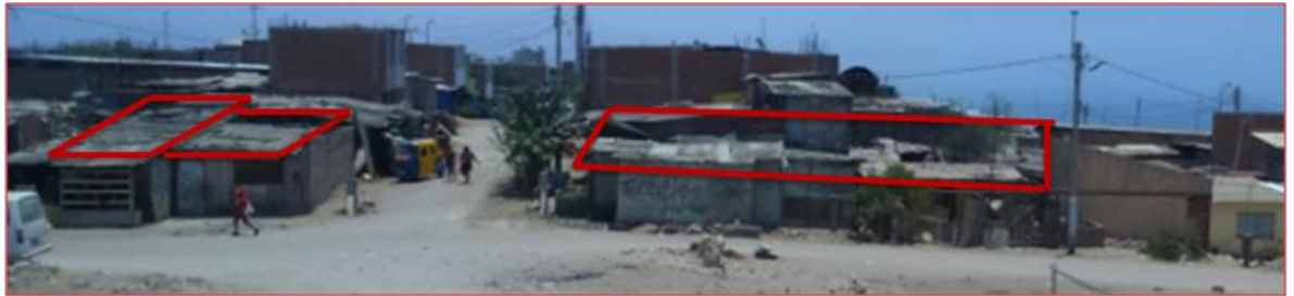
“Fotografía 5: Muestra el total techado de las viviendas no cumpliendo iluminación, ventilación de acuerdo al R.N.E., Parámetros”
