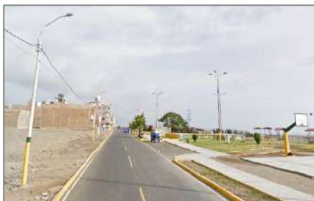
Imagen 28: Calle Costanera, Fuente: Propia
