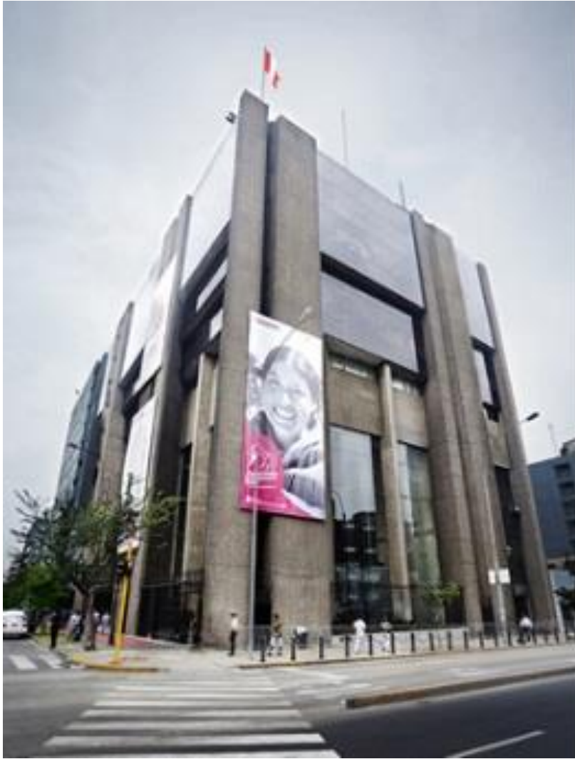
Figura 1. Fachada del Ministerio de la Mujer y Poblaciones Vulnerables. Febrero de 2017
