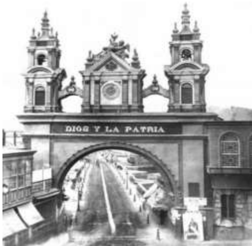
Figura 1.5 El Arco del Puente
