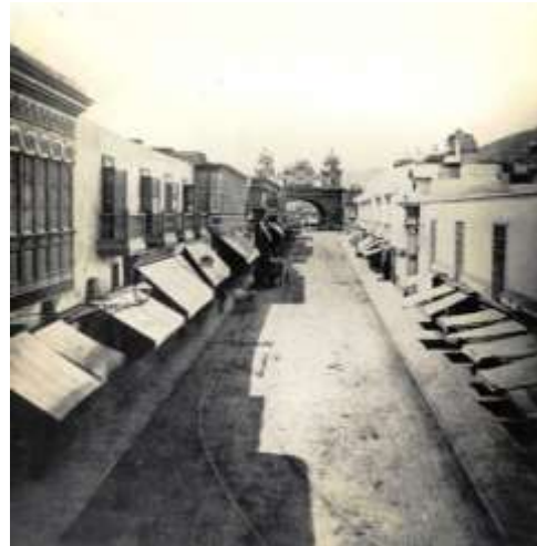
Figura 1.6 El Arco del Puente poco antes de desaparecer en un incendio.
