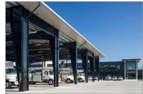
IMAGEN DE LOS TALLER DE MANTENIMIENTO
