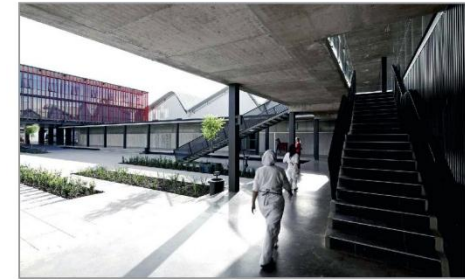
VISTA DE LA PLAZA CON ESCALERA
