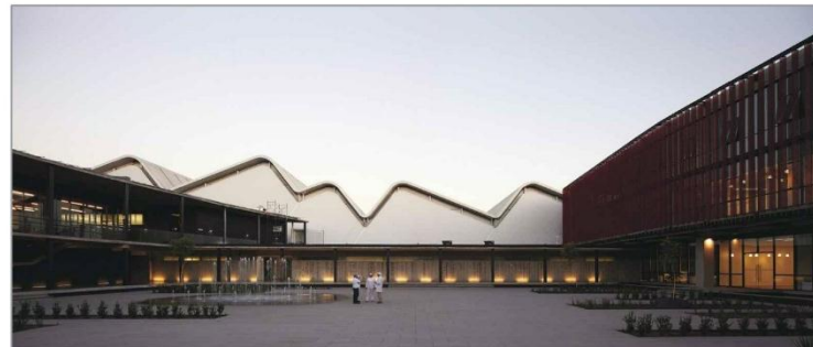
FÁBRICA CAROZZI DE VISTA INTERIOR DE LA PLAZA
