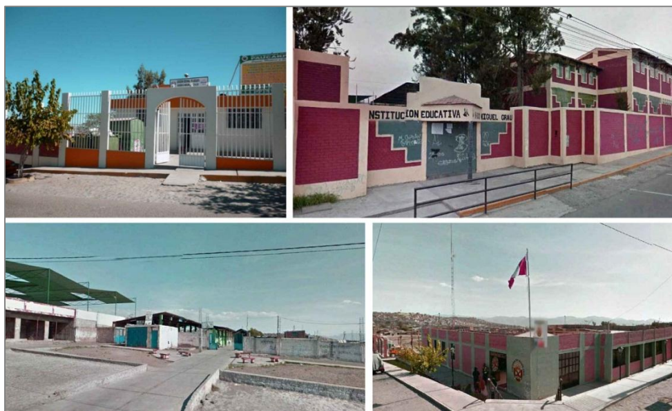
Figura 54. Vista de equipamiento. Fuente. Imágenes de Google Earth
