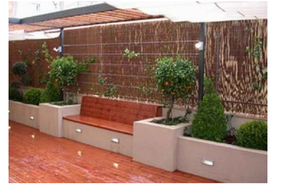
Banca de concreto con asiento de madera, jardineras con acabado microcemento
