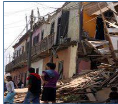
Fig.16 Colapso de vivienda
