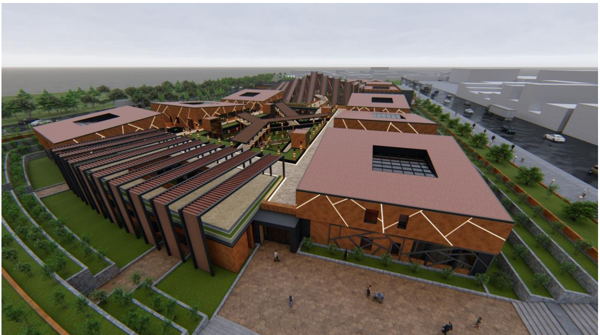
Fig. IV.25 Vista exterior, Entrada de la Zona de Investigación de Restauración
