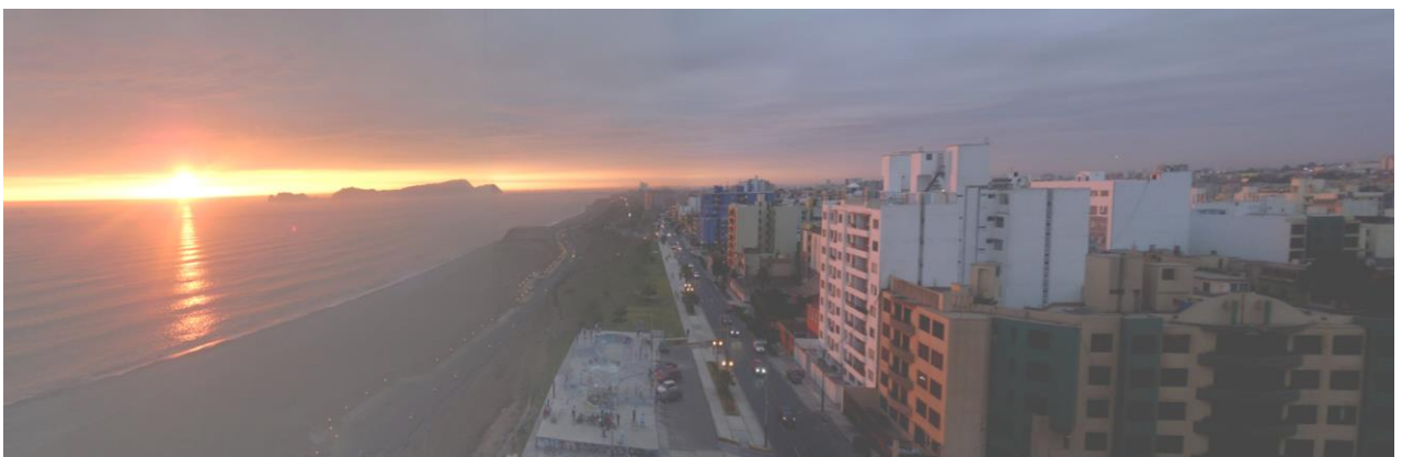
Fig. IV. 06 – Av. Costanera y la visual con el Mar
