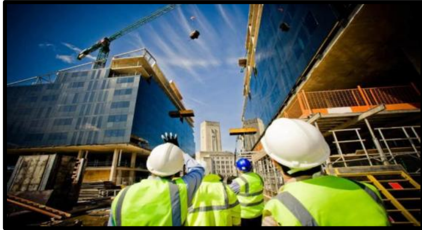
Figura 2 Construcción de edificios completos
