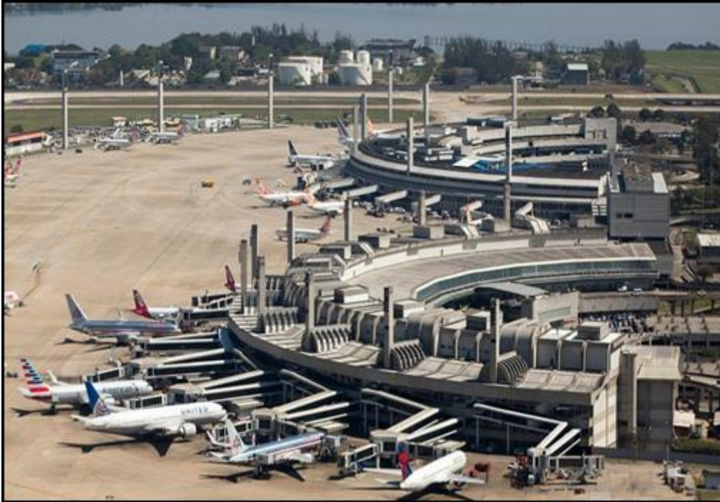
Figura 25 Infraestructura portuaria aérea
