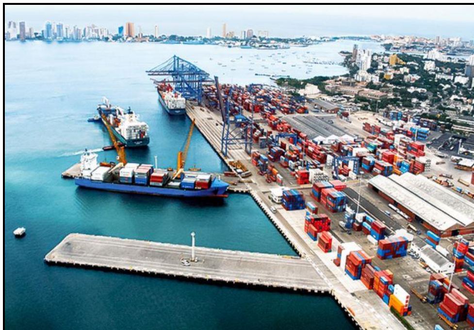
Figura 24 Infraestructura portuaria marítima
