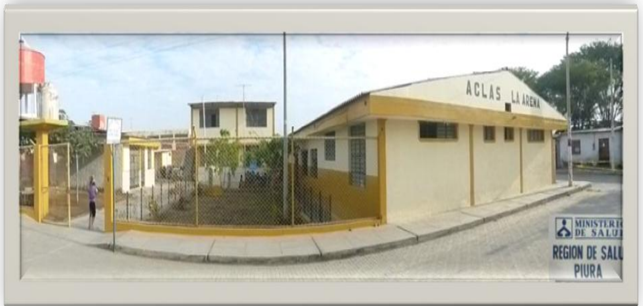
Fotografía del Centro de Salud LA ARENA
