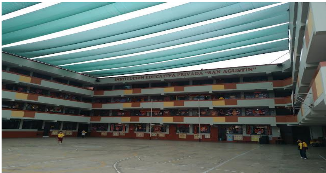
Losa deportiva del colegio San Agustín
