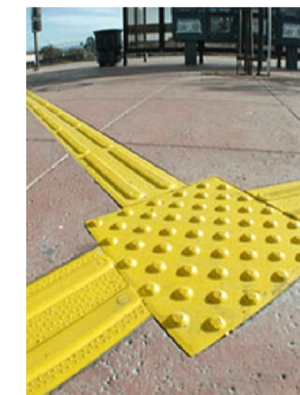
Pavimentos podotáctiles de avance y detención en todas las veredas
