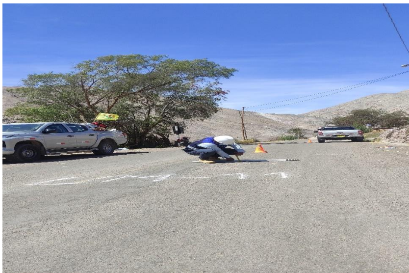
Foto 5. Se presentan la patología de huecos con mayor severidad en la calzada derecha en la U/M 11 de la vía TA-104 del km 2+000 al 3+000, región de Tacna. Fuente: Elaboración propia.
