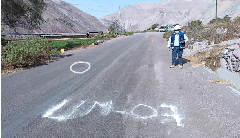
Foto 4. Se presentan la patología de parcheo con mayor severidad en la calzada derecha en la U/M 07 de la vía TA-104 del km 2+000 al 3+000, región de Tacna. Fuente: Elaboración propia.
