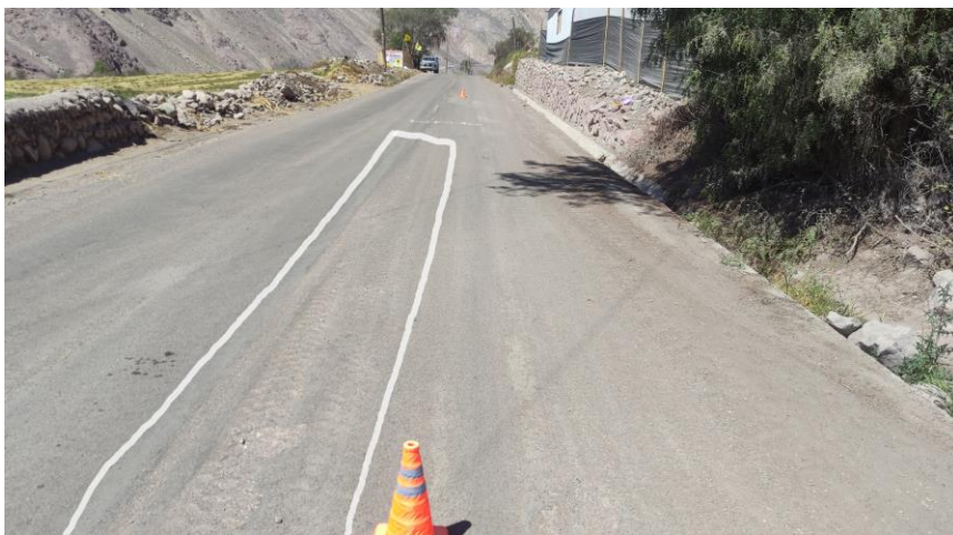
Foto 6. Se presentan la patología de ahuellamiento con mayor severidad en la calzada derecha en la U/M 09 de la vía TA-104 del km 2+000 al 3+000, región de Tacna. Fuente: Elaboración propia.
