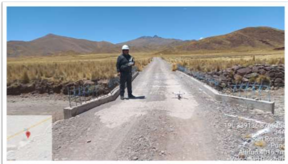
Vista de dron fotogramétrico en zona de trabajo
