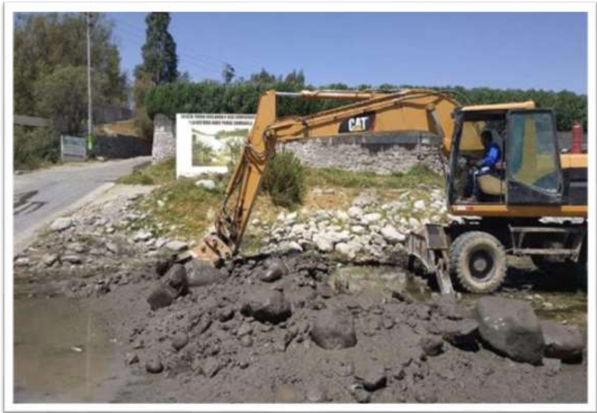
Vista panorámica de la realización de calicata retroexcavadora CAT.
