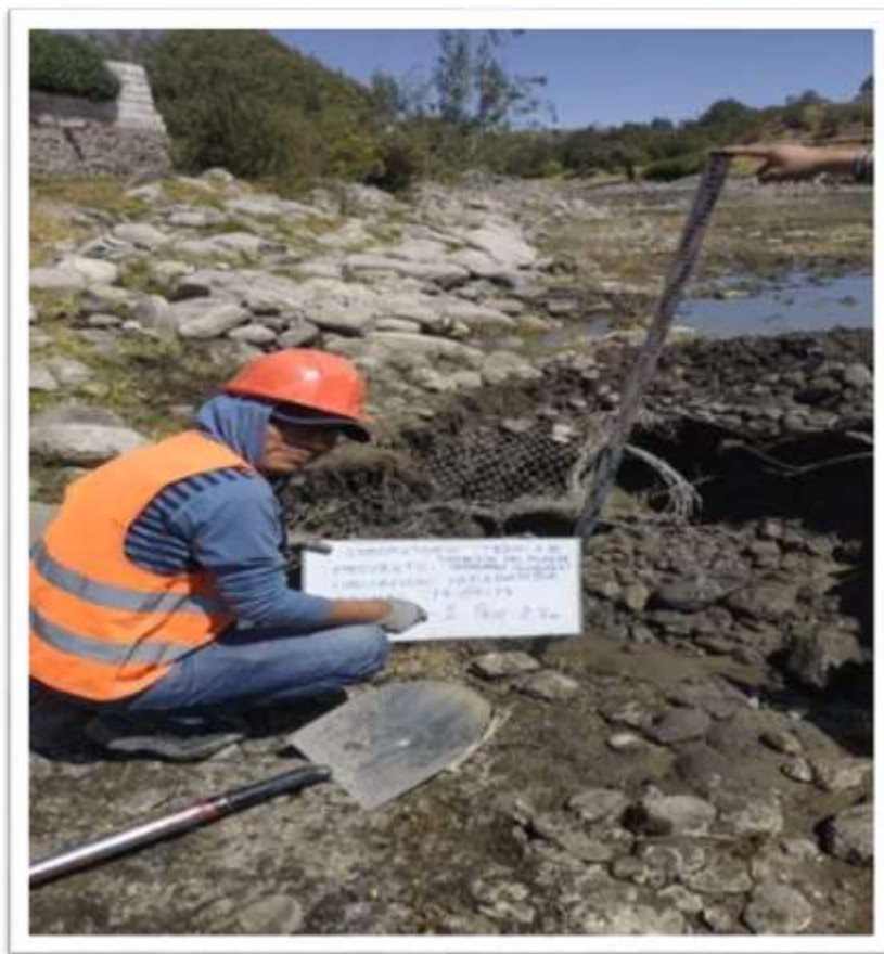
Vista panorámica del estudio de suelo calicata.
