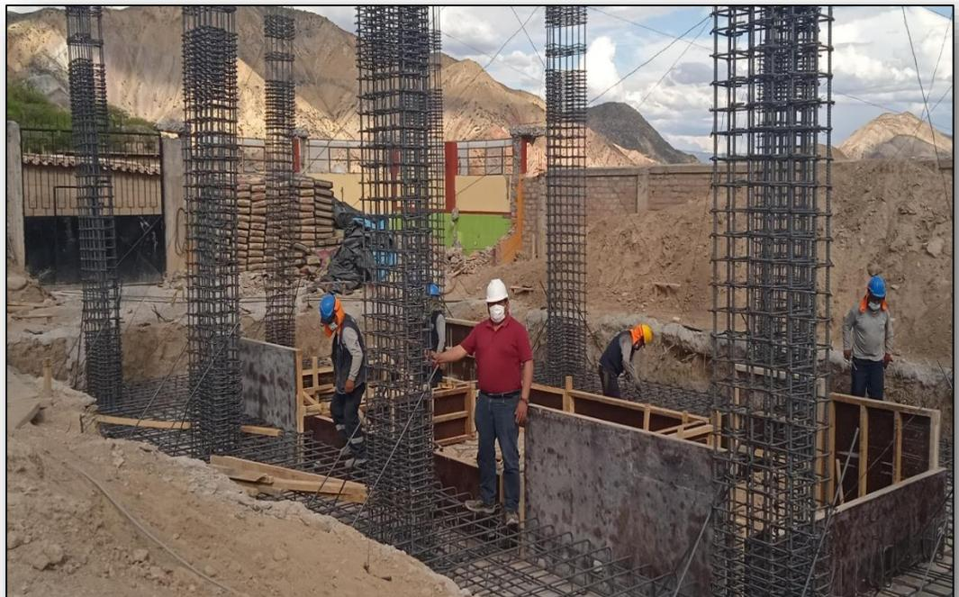
**FOTO 14: HABILITACIÓN DE MADERA, PARA ENCOFRADO**
