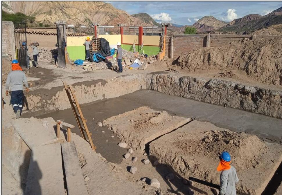
**FOTO 12: VACIADO DE FALSA ZAPATA EN EL MÓDULO I, CON CONCRETO F'C
