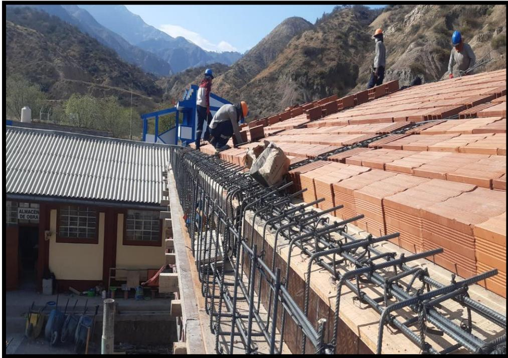
FOTO 27: ARMADO DE ESTRUCTURA PARA VIGA CANAL.
