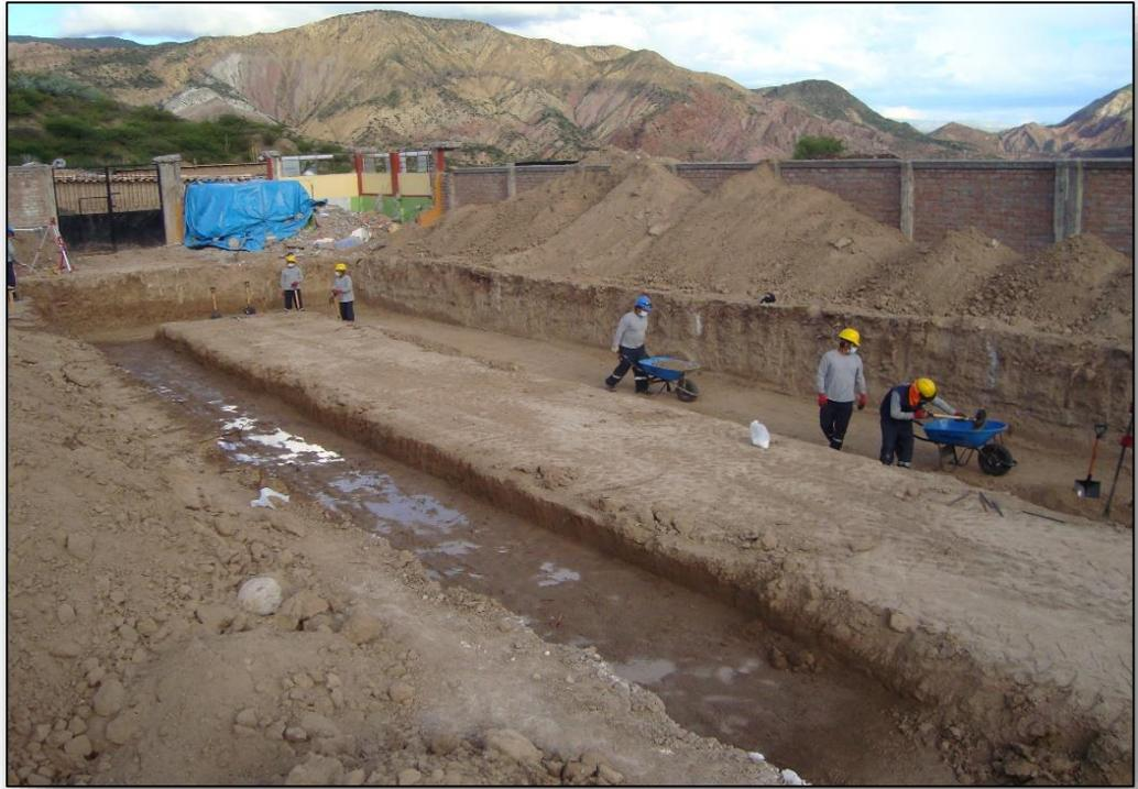
**FOTO 11: CORTE DE TERRENO Y PERFILADO**
