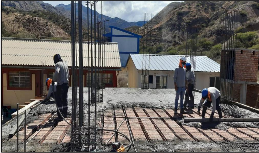
FOTO 21: VACIADO DE LOSA CON CONCRETO F'C 210 KG/CM2
