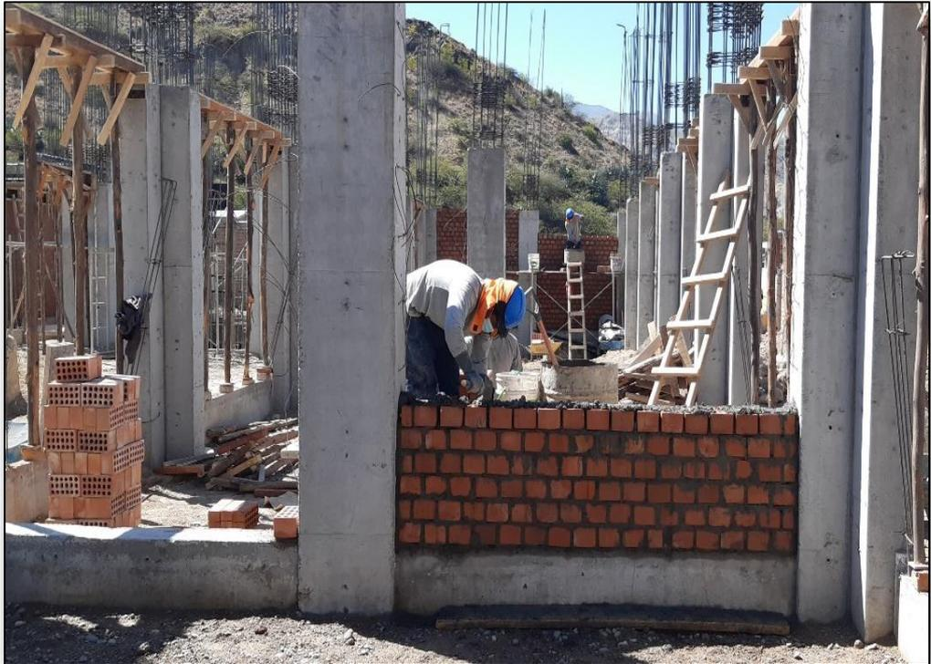
**FOTO 19: ASENTADO DE LADRILLOS DE CABEZA A EN MODULO**
