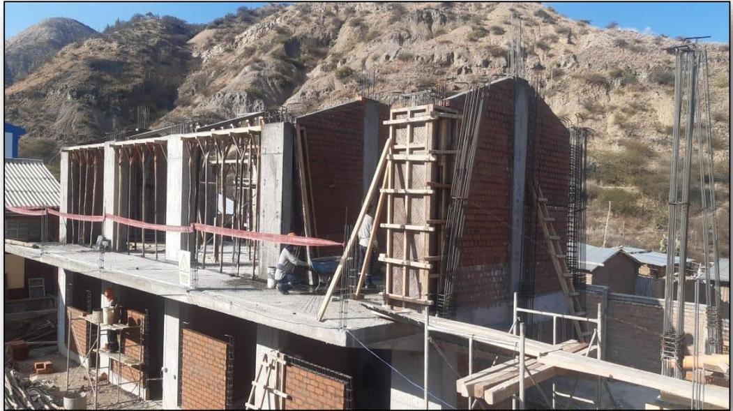
**FOTO 25: ENCOFRADO DE COLUMNAS**
