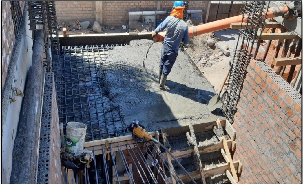
.....FOTO 23: VACIADO DE ESCALERA CON CONCRETO 210 KG/CM2.
