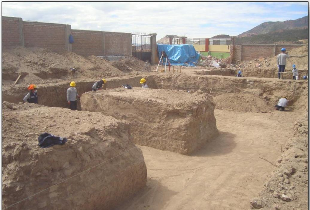
**FOTO 10: CORTE DE TERRENO PARA ZANJAS, PERFILADO DE TERREMO MANUAL**
