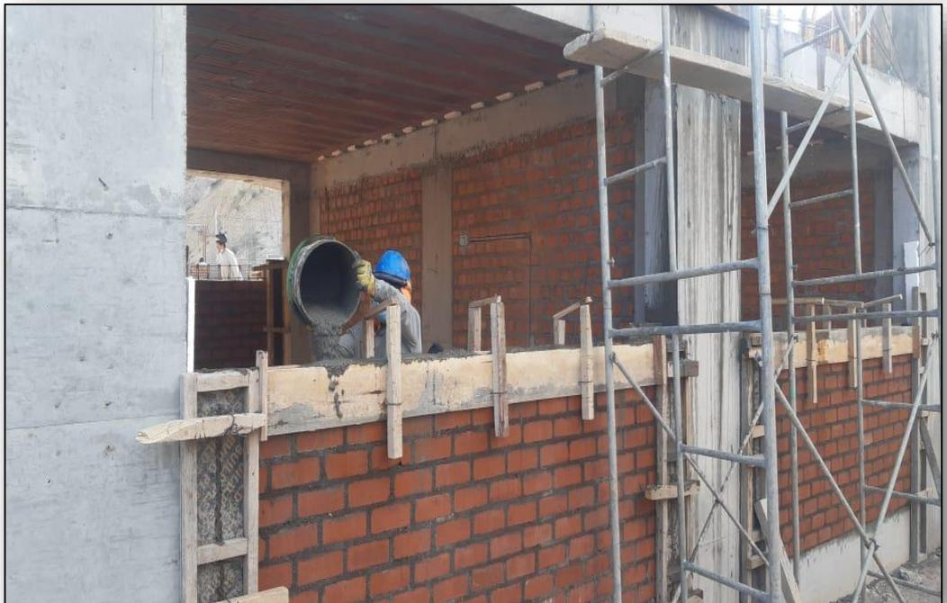
FOTO 24 ENCOFRADO Y DEENCOFRADO, VACIADO DE COLUMNAS Y COLUMNETAS CON CONCRETO 210 KG/CM2.
