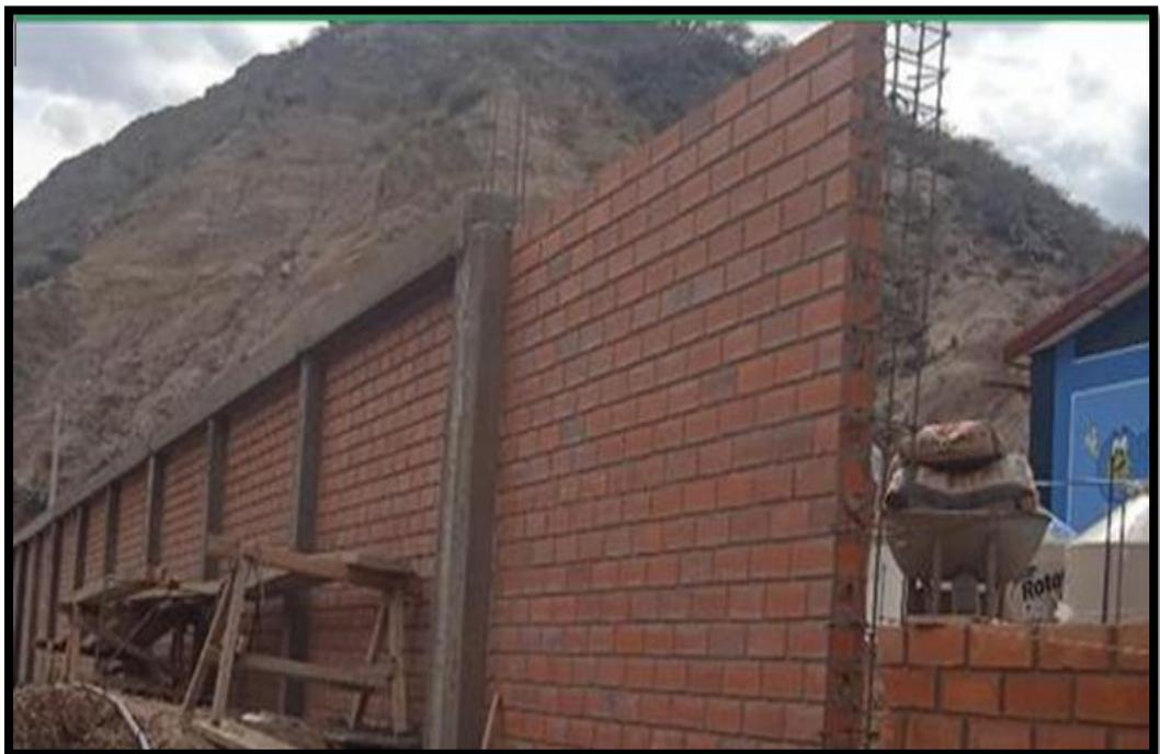
FOTO 28: ASENTADO DE LADRILLOS EN CERCO PERIMÉTRICO.
