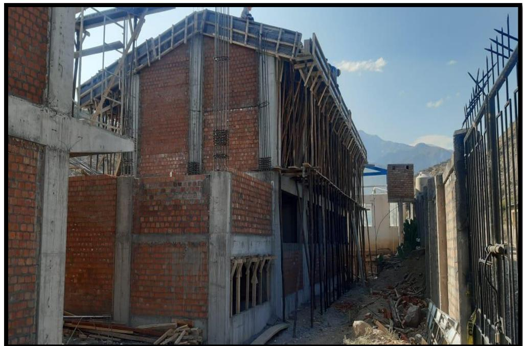
**FOTO 26: ENCOFRADO DE LOSA ALIGERADA SEGUNDO PISO**
