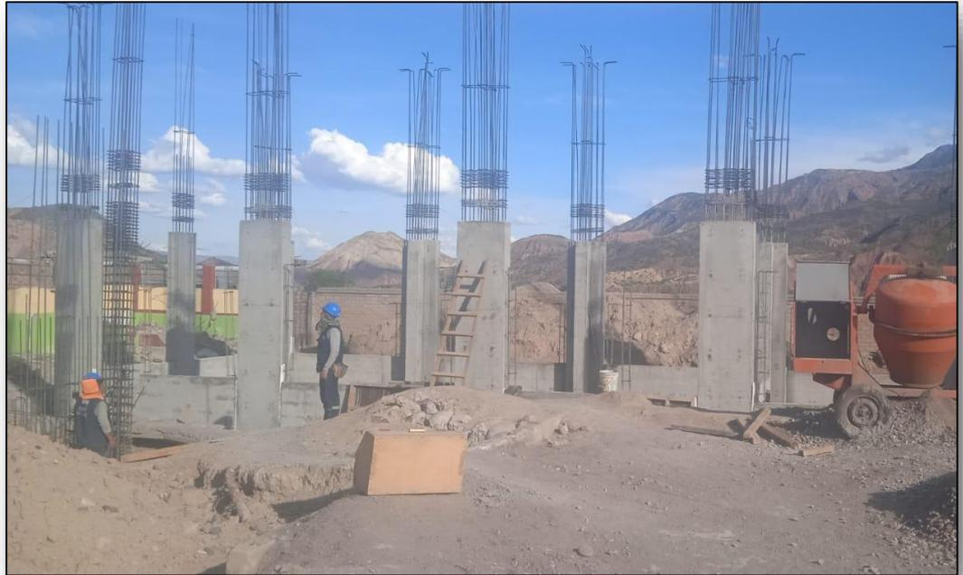
**FOTO 15: VACIADO DE CONCRETO F'C = 210 KG/CM**
