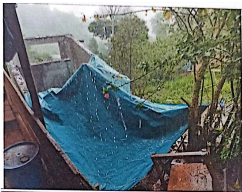
Foto 5 Unidad Básica de Saneamiento
