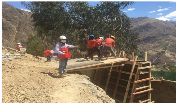
Foto 4: Encofrado y Vaciado de muro de contención.
