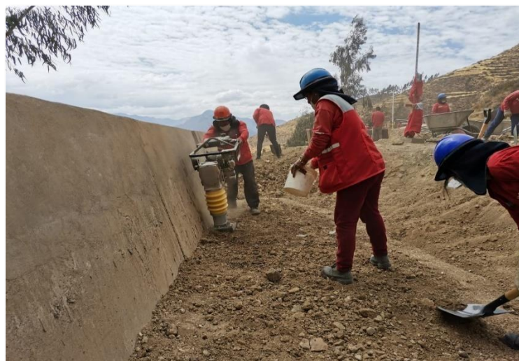
Foto 7: Relleno con material propio en el muro de contención.
