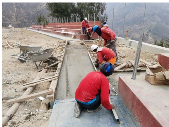
Foto 10: Construcción de veredas. Fuente: Elaboración Propia.
