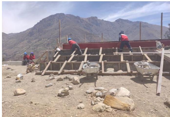
Foto 8: Encofrado de Gradas y Graderías Fuente: Elaboración Propia
