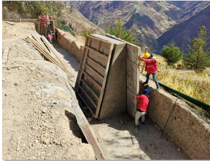
Foto 5: Desencofrado del cuerpo del muro de contención.
