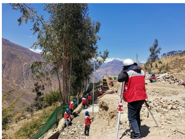
Foto 1: Nivelación con equipo topográfico. Fuente: Elaboración Propia
