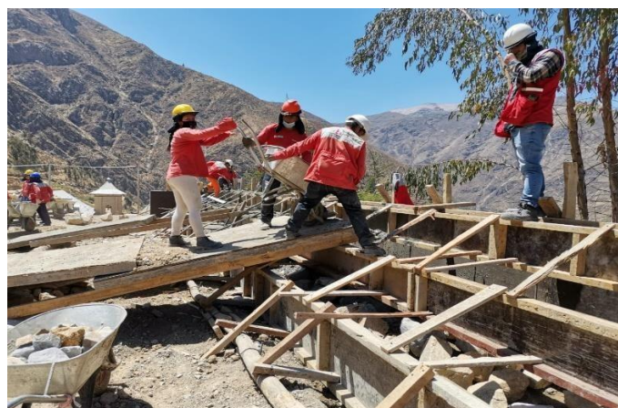
Foto 8: Encofrado de Gradas y Graderías Fuente: Elaboración Propia
