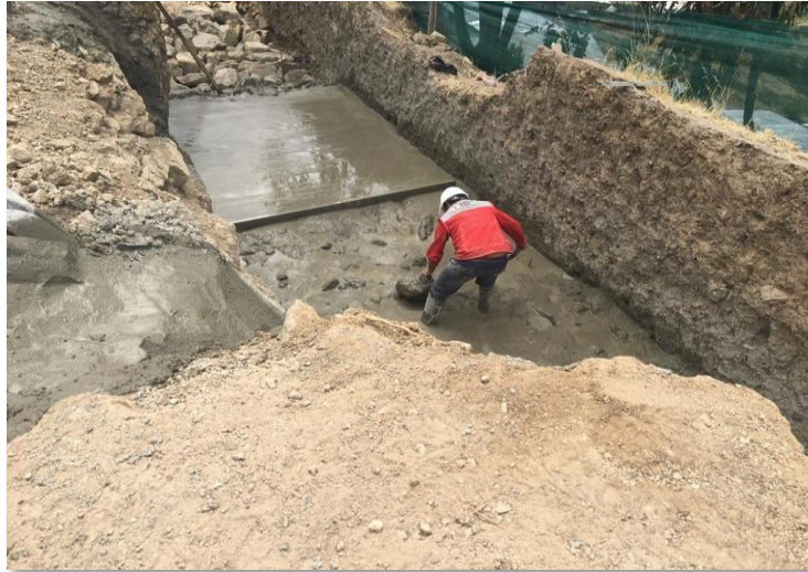
Foto 3: Vaciado de concreto de la zapata Fuente: Elaboración Propia
