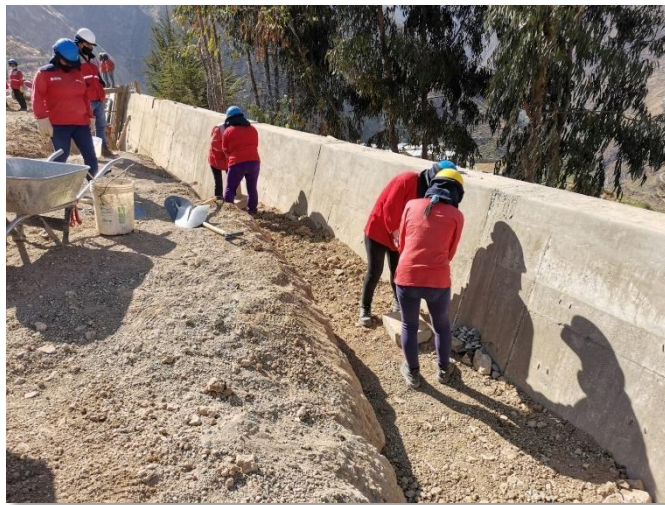
Foto 6: Muro de contención de concreto ciclópeo en Allauca.
