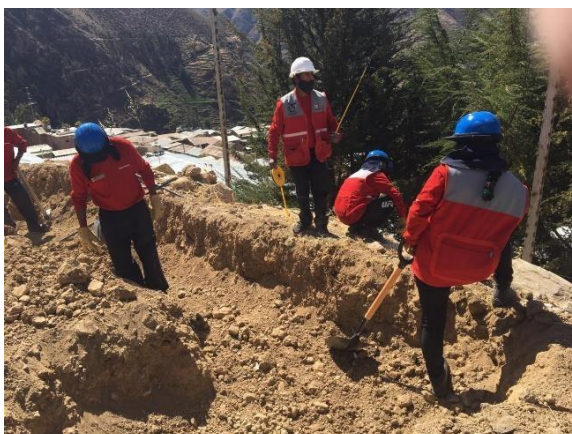
Foto 2: Excavación manual Fuente: Elaboración Propia.
