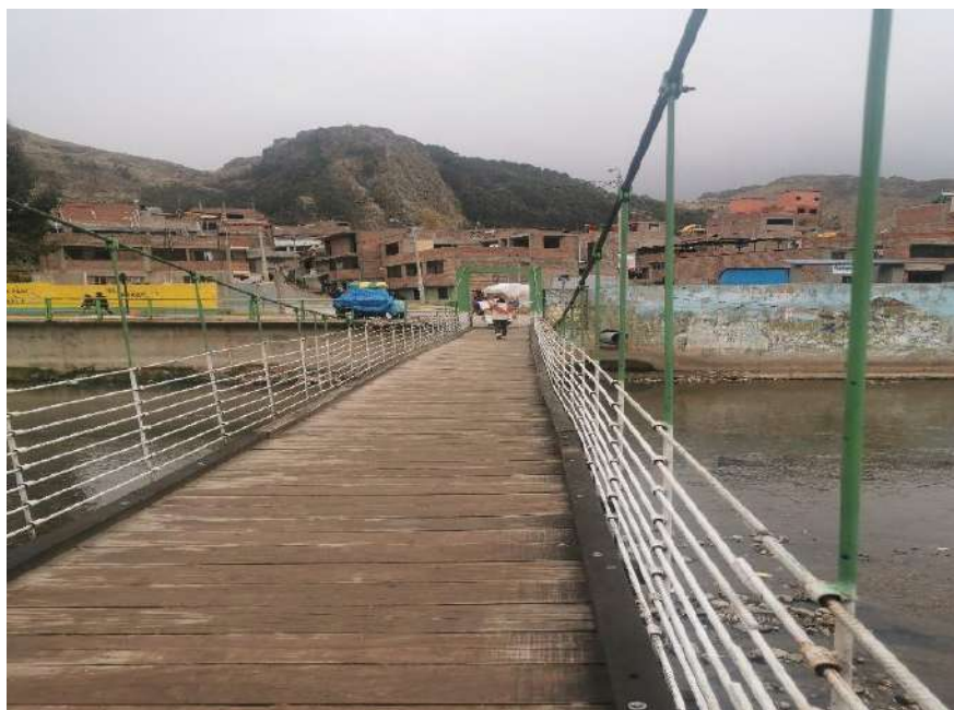
Foto 7.2: Vista del Área del puente actual Fuente: Expediente técnico
