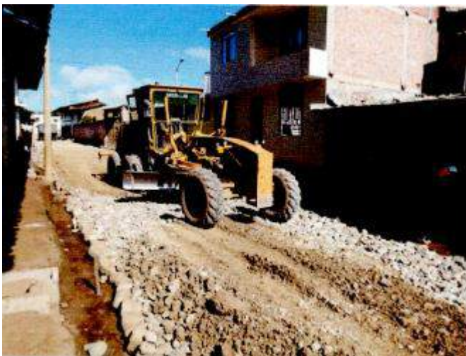
Foto 4: Espaciamiento de forma homogénea al afirmado.
