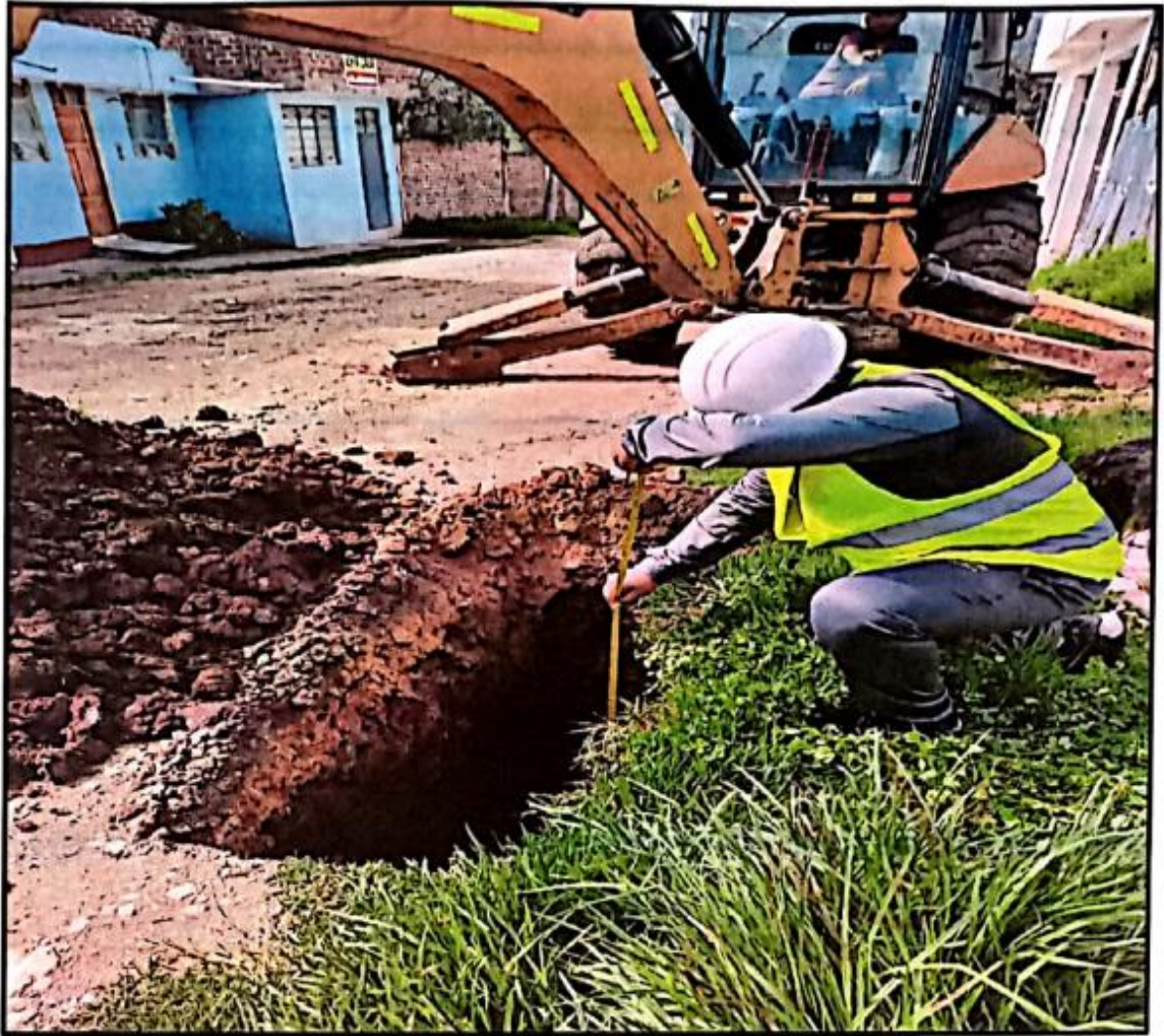
FOTOGRAFIA N°07: MEDIDA DE PROFUNDIDAD +2.50M DE LA CALICATA C-2 EN EL JR. ESPAÑA CUADRA 1.
