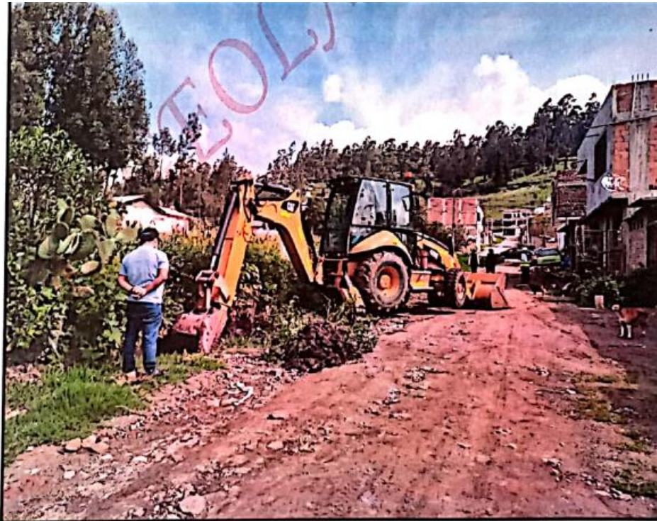
FOTOGRAFIA N°08: EXCAVACION DE LA CALICATA C-3 EN EL JR. FRANCIAS CUADRA 2.
