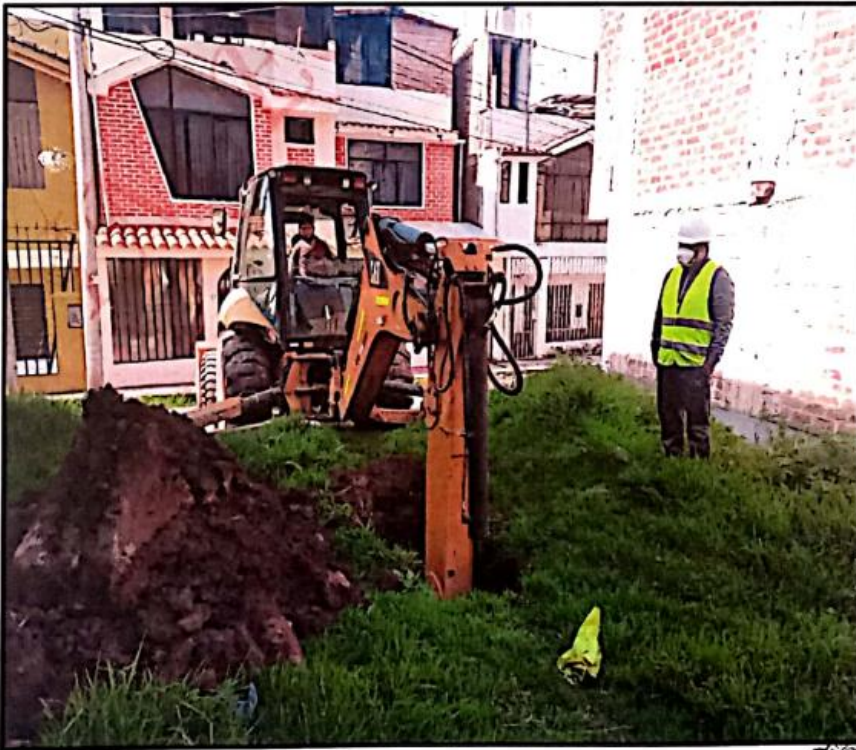
FOTOGRAFIA N°02: EXCAVACION DE LA CALICATA C-1 EN EL JR. ESPAÑA
