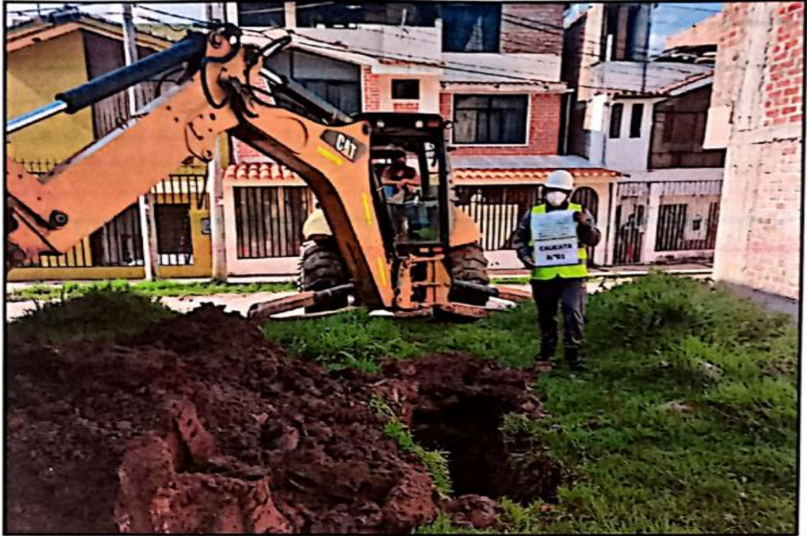
FOTOGRAFIA N°03: EXCAVACION DE LA CALICATA C-1 EN EL JR. ESPAÑA
