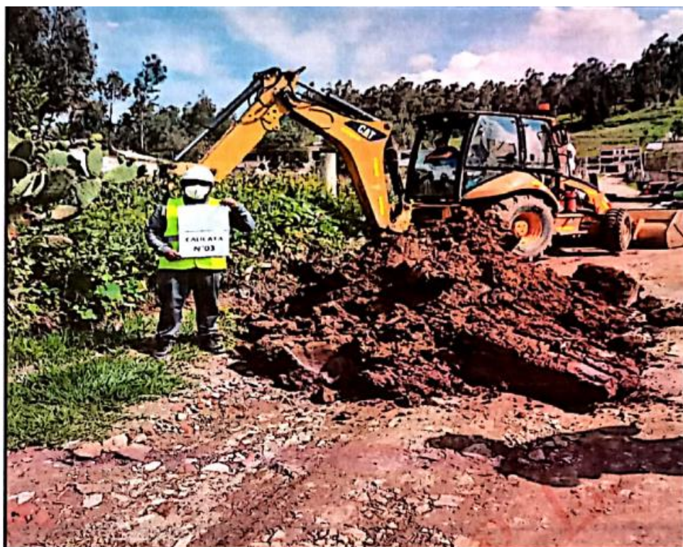
FOTOGRAFIA N°09: EXCAVACION DE LA CALICATA C-3 EN EL JR. FRANCIAS CUADRA 2
