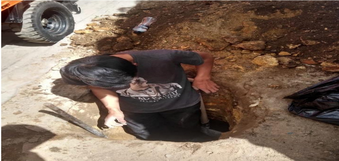
Fotografía 4. Excavación de la calicata N° 02
