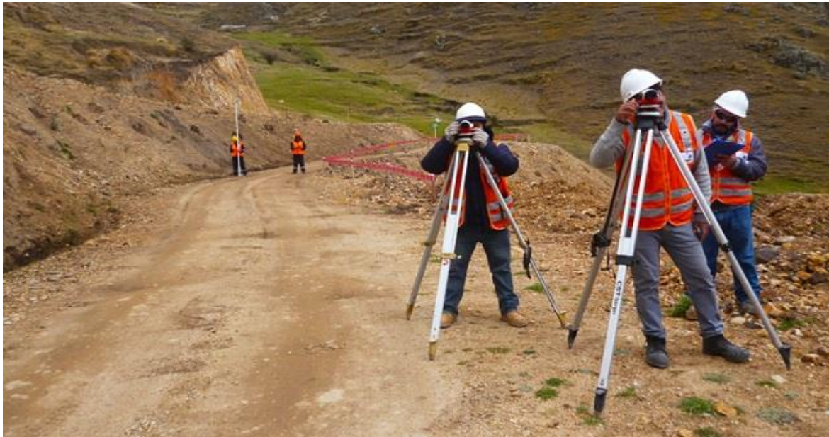
Fotografía 2. Realizando el levantamiento topográfico correspondiente - Jr. N°01 centro poblado pilcos
