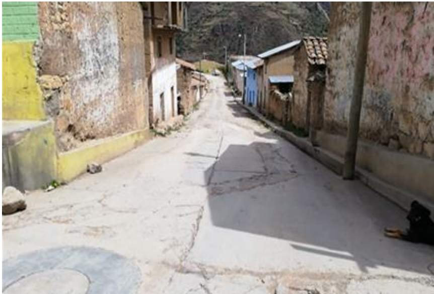
Fotografía 1. El Jr. Tupac Amaro se aprecia en pésimas condiciones
