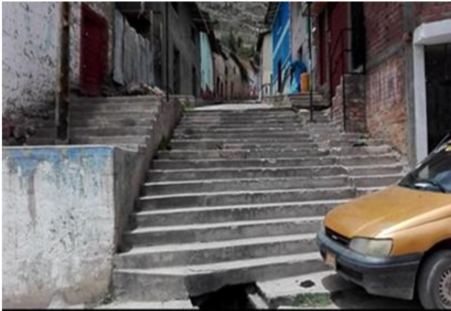
Fotografía 11. Se aprecia las graderías en pésimas condiciones para los peatones.
