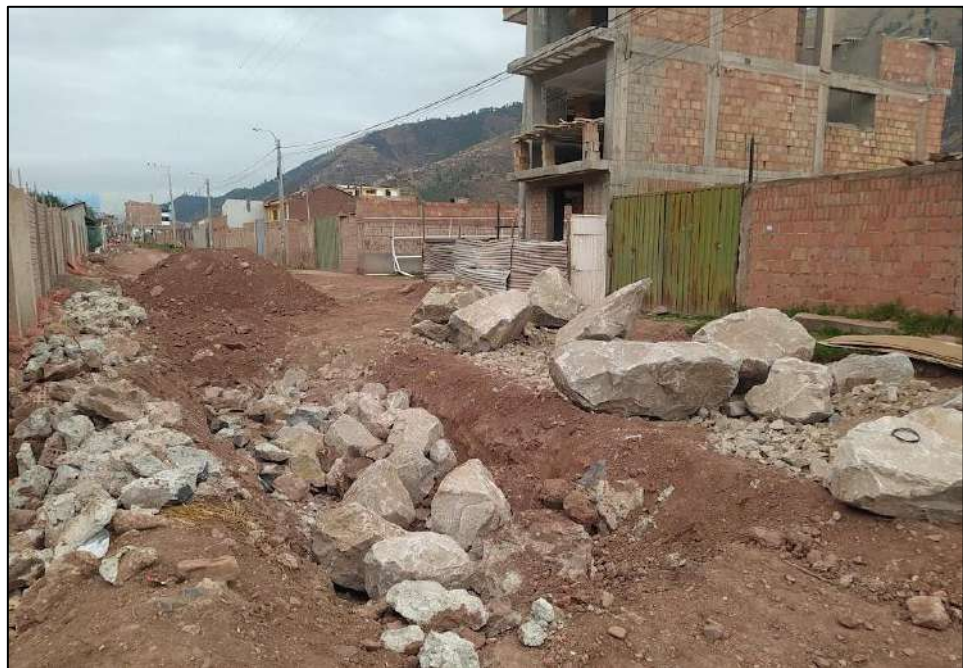
Foto 4. Proceso de mejoramiento de subrasante mediante enrocado
