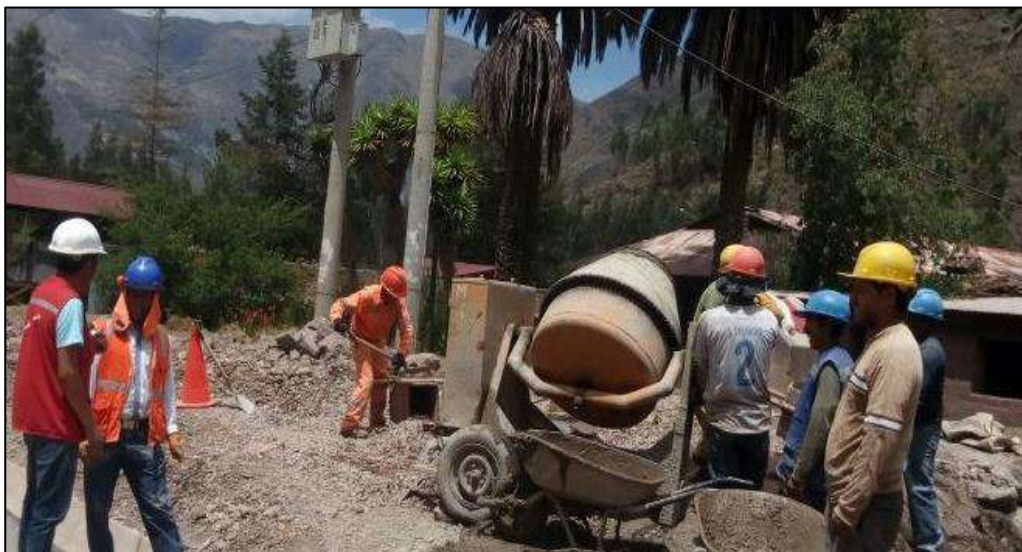
Foto 6. Control de dosificación del concreto
