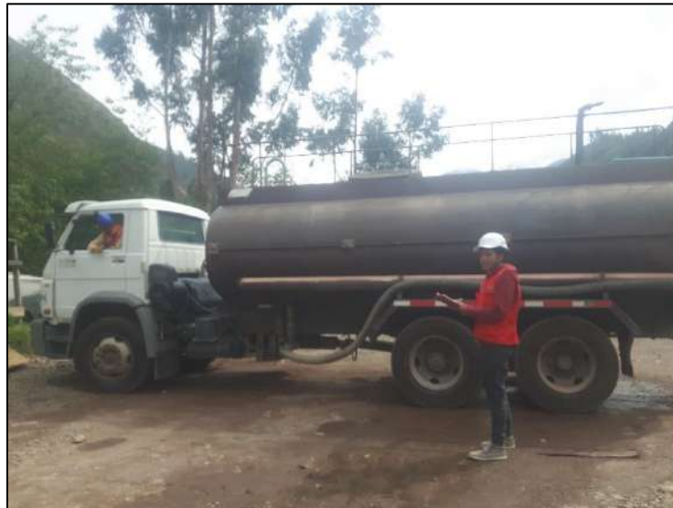
Foto 5. Control de materiales y maquinaria
