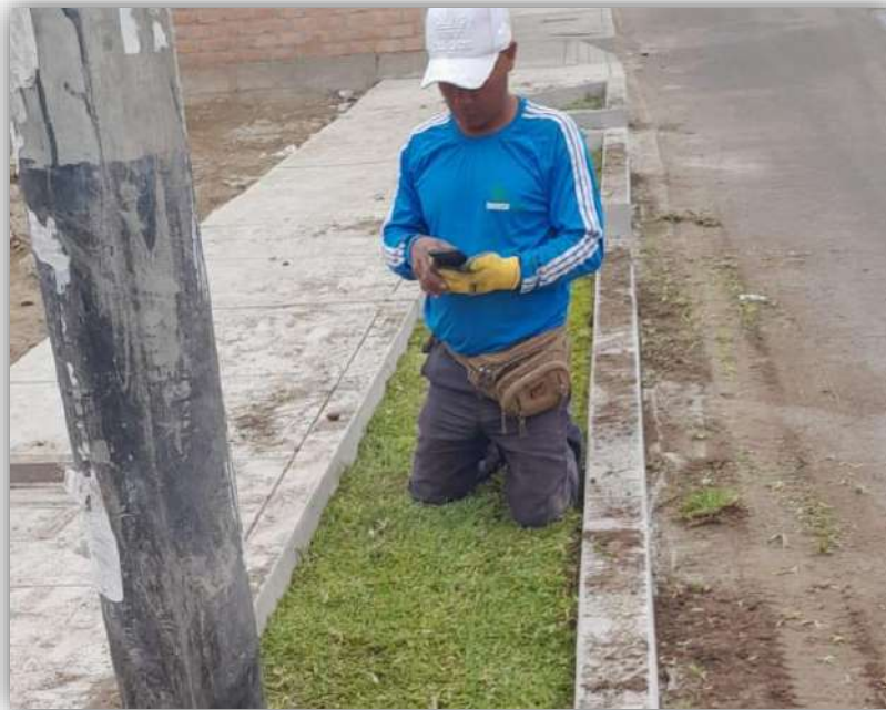
Foto N° 25: Colocación de juntas asfálticas
