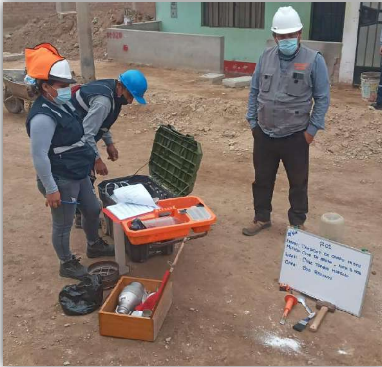
Foto N° 15: Ensayos de Proctor modificado – determinando la densidad y humedad
