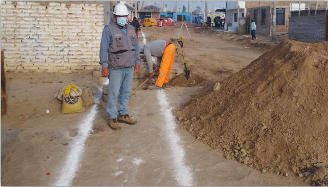
Foto N° 11: Demoliciones manuales con rotomartillo en las veredas existentes
