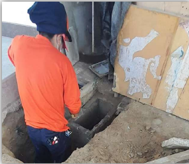
Foto N° 23: Construcción de rampas, veredas y sardineles
