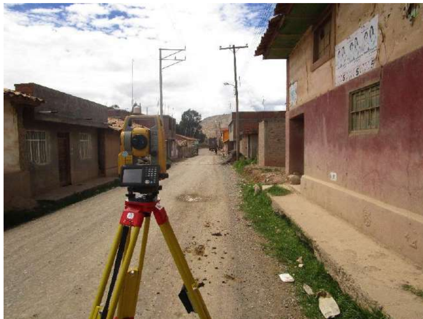
Foto N°6: Levantamiento topográfico de la vía a detalle.
