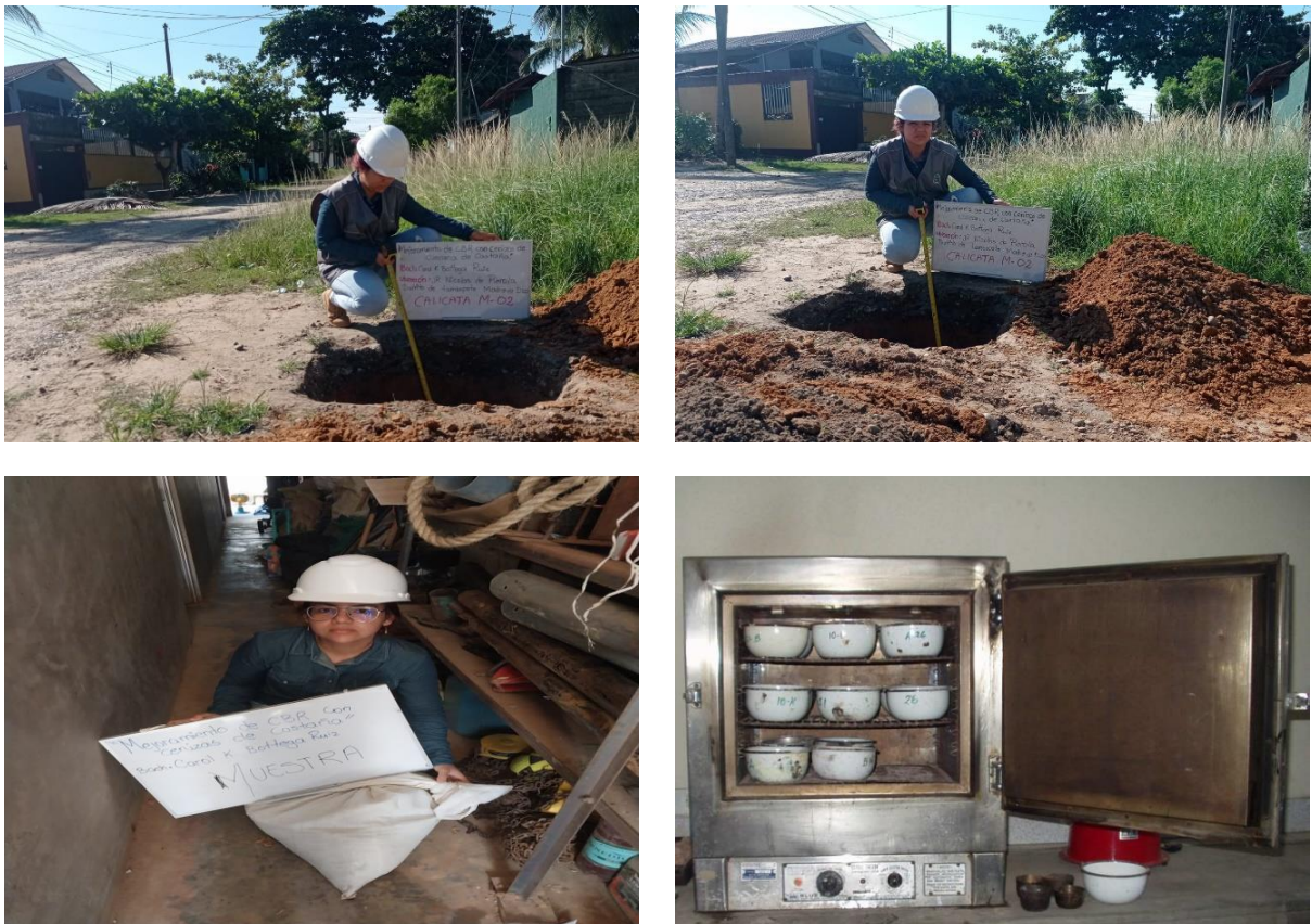
Foto 3 Excavación de Calicatas y Muestreo
