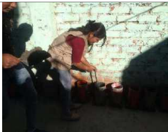
Fotografía 11. Chuseando la mezcla del concreto
