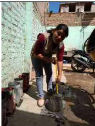
FOTOGRAFIA 31. Prueba del slump
