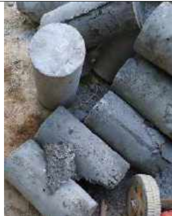
FOTOGRAFIA 01. Se observa que el concreto tenía mucho PET
