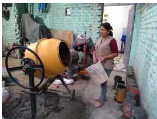
Fotografía 12. Dosificando el concreto
