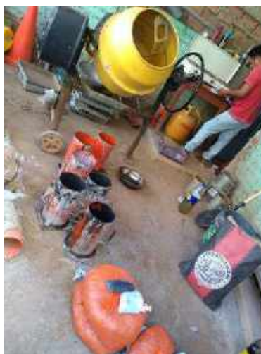
Fotografía 9. Materiales a utilizarse para el concreto
