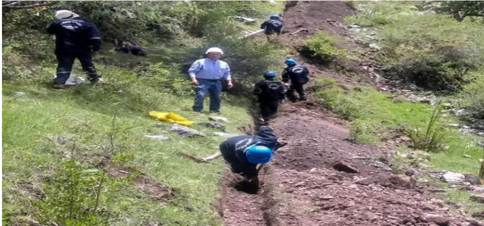
Foto 03: Relleno con cama de apoyo
