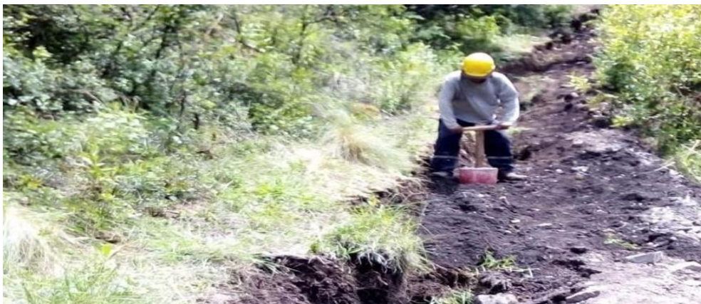
Foto 04: Relleno y compactación de zanja
