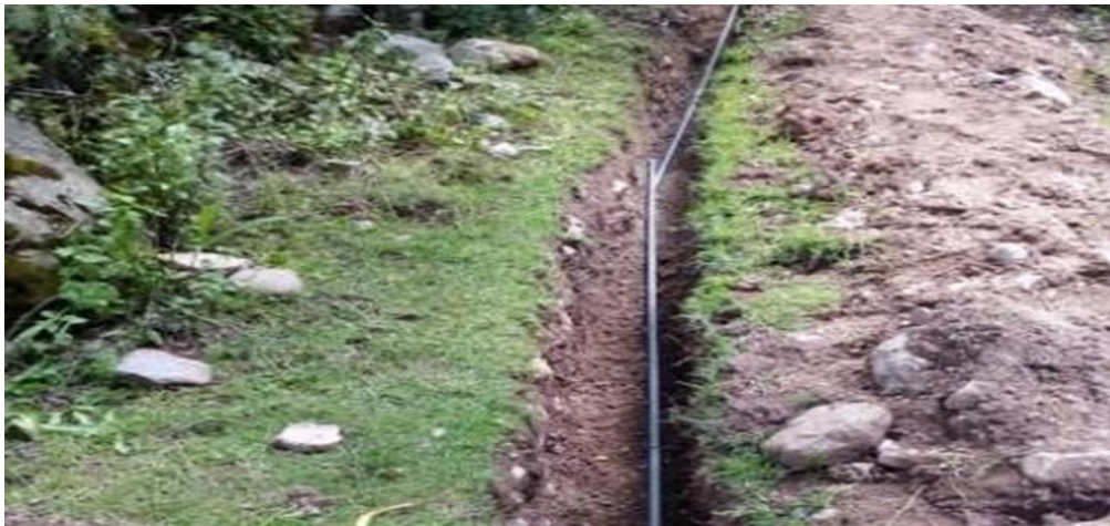
Foto 05: Instalación de tuberías
