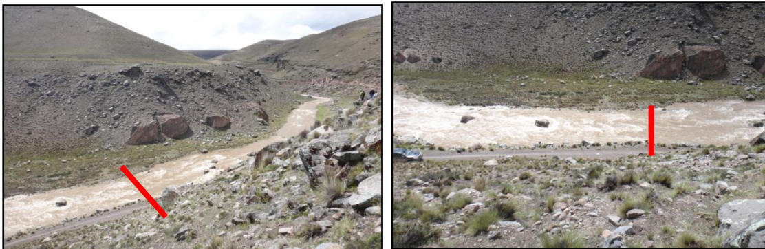
Figura 07. Proyección del barrage final de la Bocatoma el Vado.
