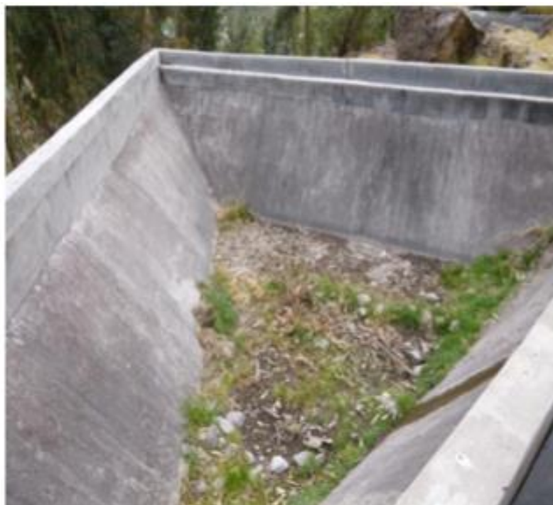
Fotografía 4 Desarenador inoperable
