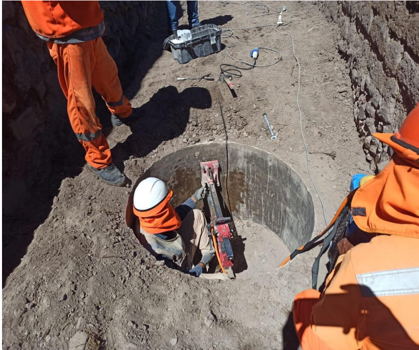
Fotografía 19 Encofrado de buzones
