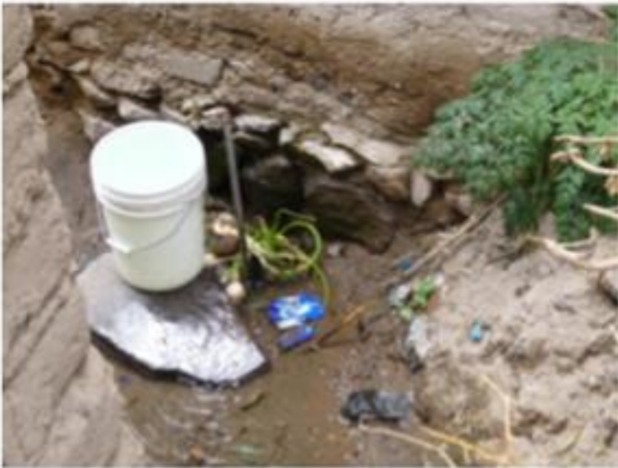
Fotografía 12 Estado de las conexiones
