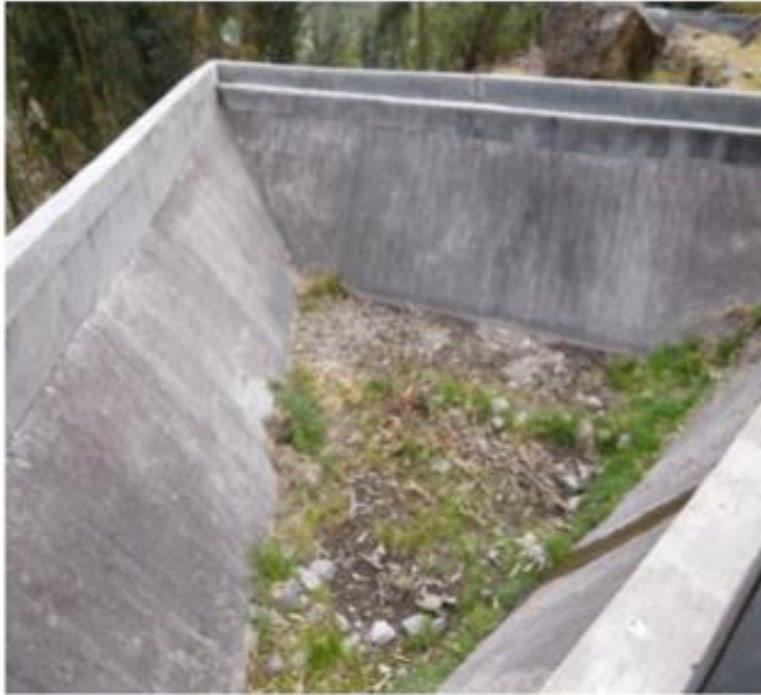
Fotografía 1 Desarenador inoperable
