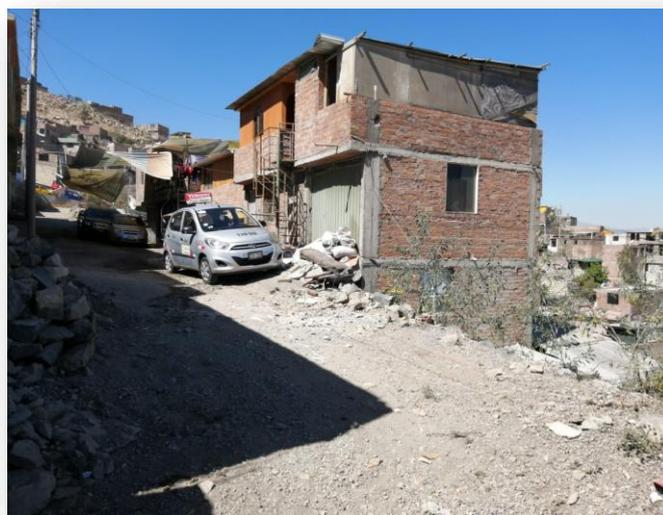
*Nota: Se visualiza el tramo II en el que se realizará la construcción de muros de contención. Se realizó la calicata II para diagnosticar el material existente y el tipo de refuerzo estructural que se aplicara.*
