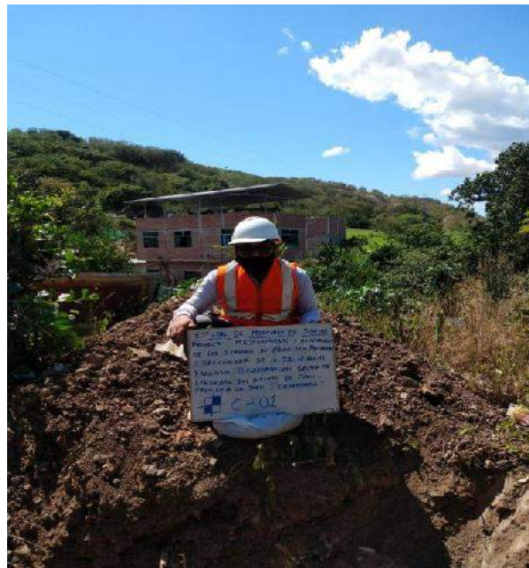
Fotografía 2 Vista De La Calicata C-01, Del Proyecto
