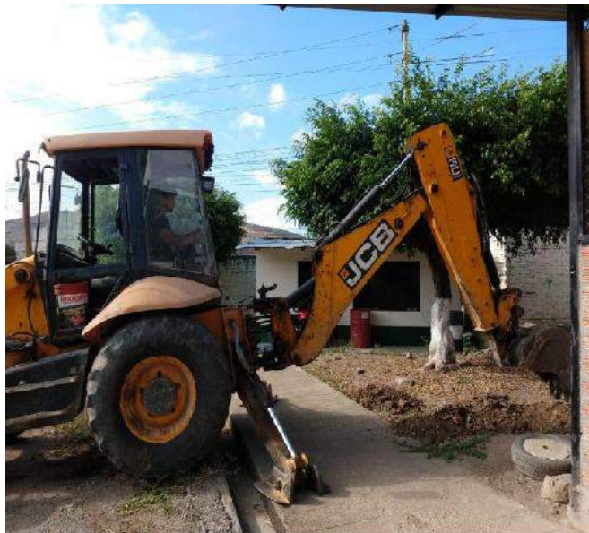
Fotografía 8 Muestra excavación de la calicata C-07, Del Proyecto
