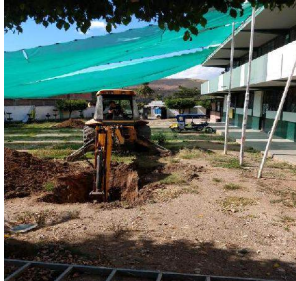
Fotografía 3 Muestra excavación de la calicata C-02, Del Proyecto
