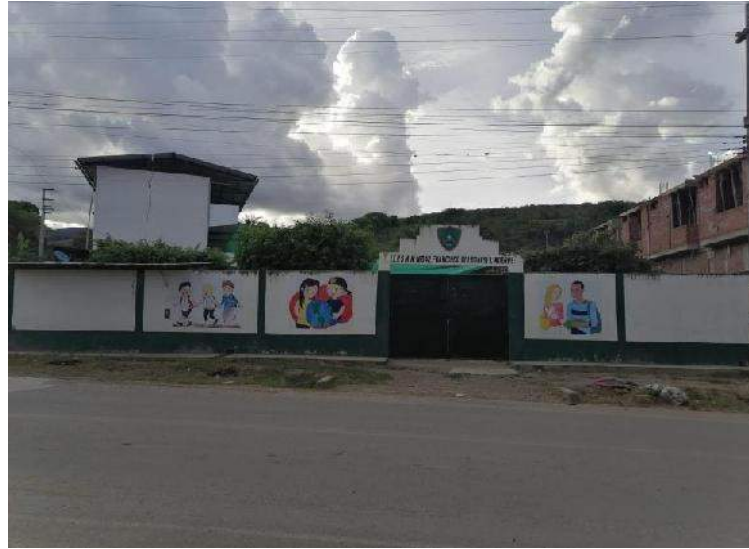
Fotografía 1 Muestra La Vista Panorámica Del Ingreso Principal A La I.E. Francisco Bolognesi Del Sector Linderos, Distrito De Jaén, Provincia Jaén, Departamento De Cajamarca.
