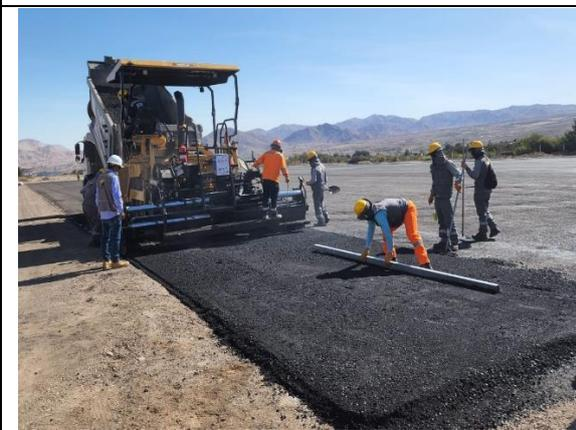
Foto 21: Colocado de carpeta asfalto
