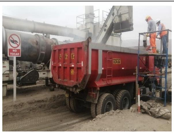
Foto 24: : Despacho de asfalto caliente de planta
