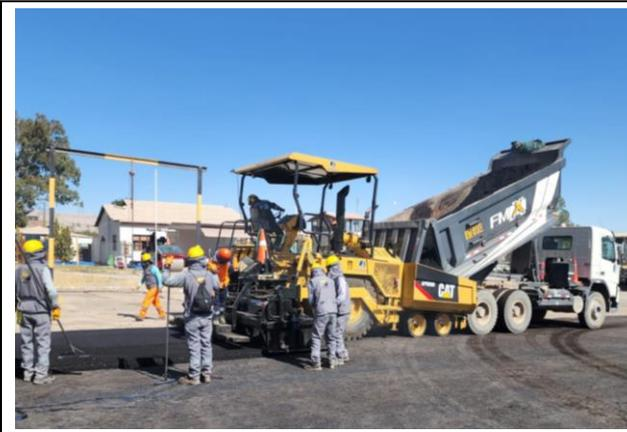
Foto 25: Colocado de carpeta asfáltica
