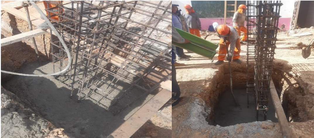
Fotografía 8: Verificación y colocación y verticalidad de columna
