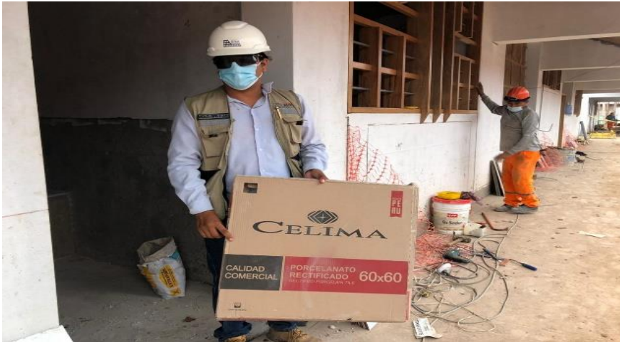
Fotografía 3: Verificación de porcelanato utilizado en la obra
