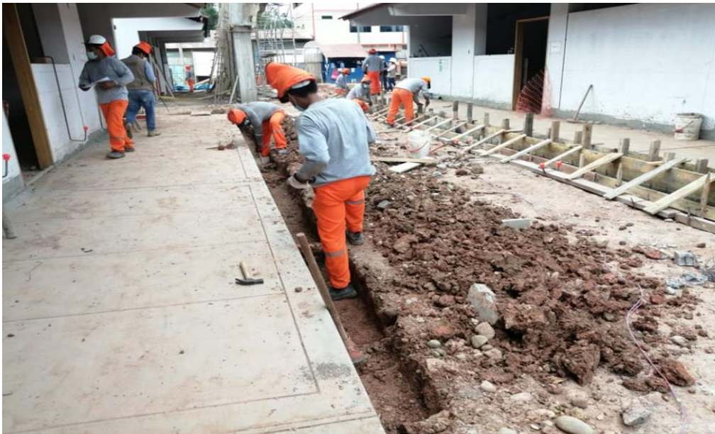
Fotografía 11: Verificación de sobrecimientos
