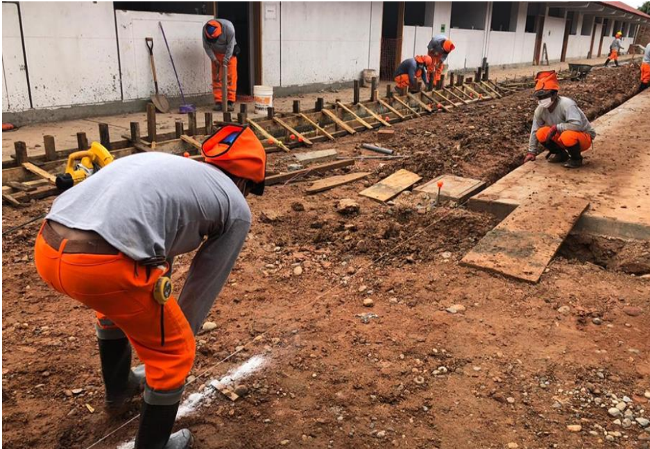
Fotografía 4: Verificación de trazo y replanteo
