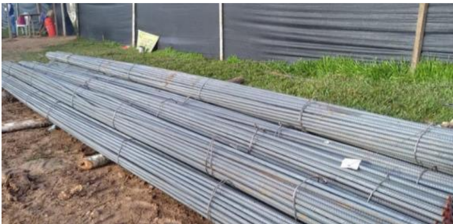
Fotografía 2: Acero de refuerzo utilizado en obra
