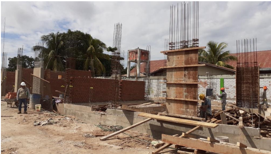
Fotografía 10: Verificación de sobrecimientos
