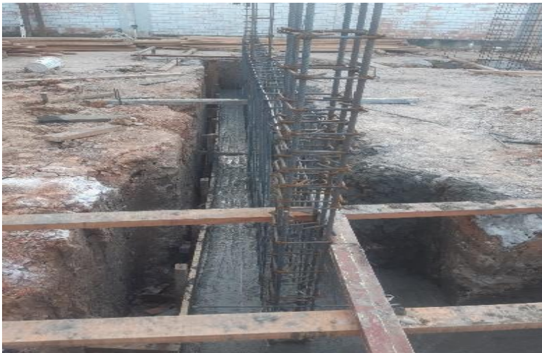
Fotografía 9: Verificación de vaciado de cimentación
