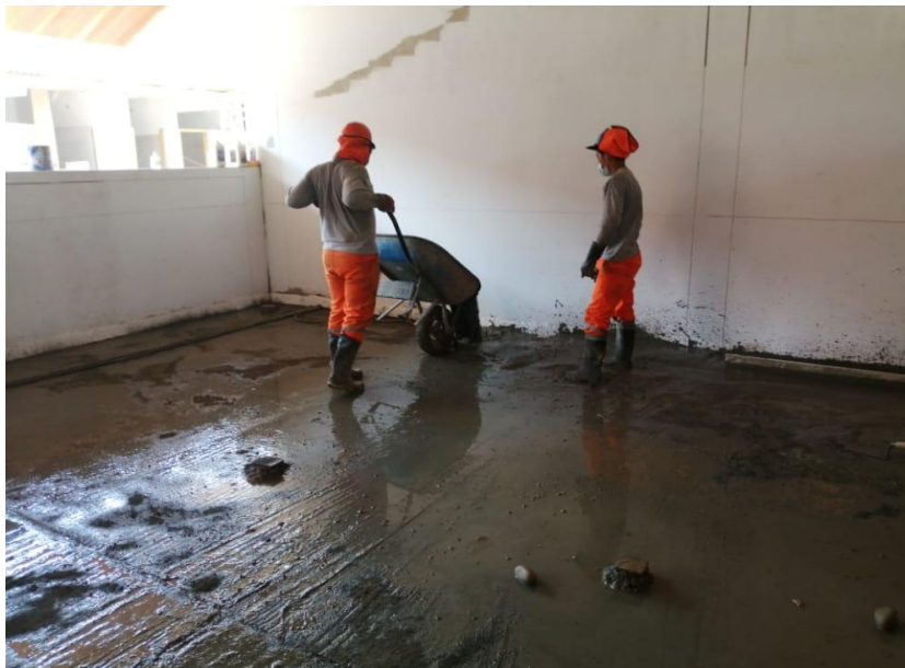
Fotografía 6: Verificación de vaciado de falso piso
