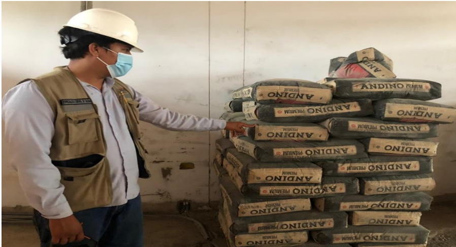
Fotografía 1: Verificación de almacenamiento y tipo de cemento utilizado
