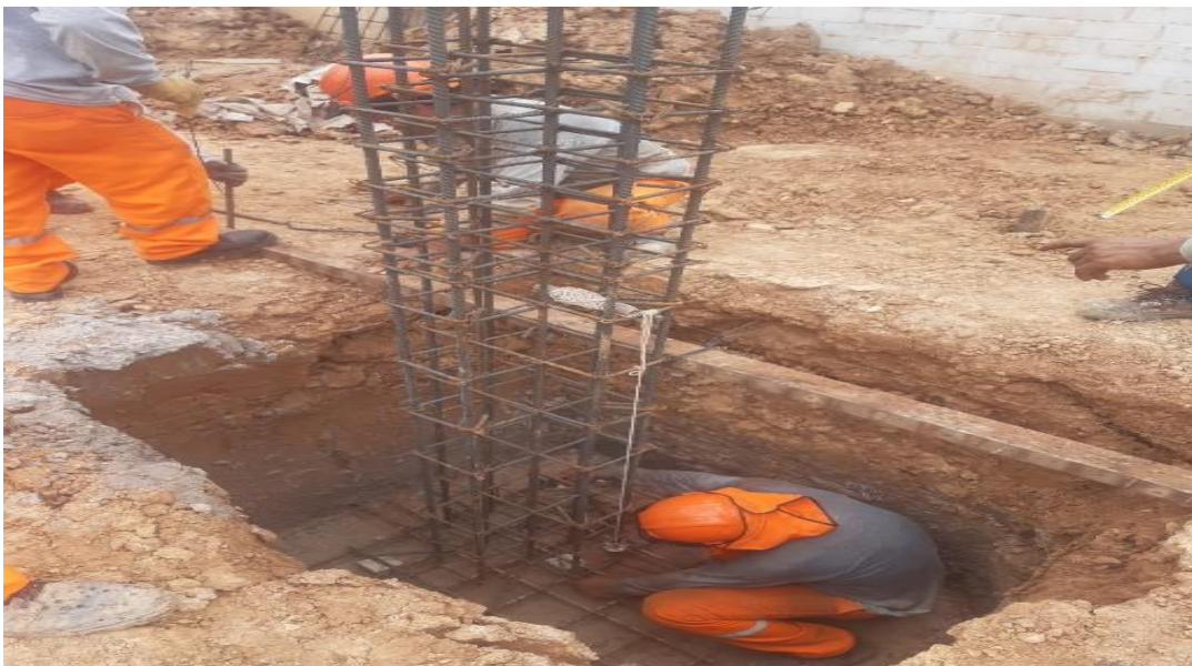
Fotografía 8: Verificación y colocación y verticalidad de columna
