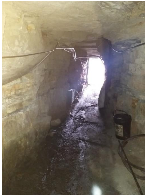
Imagen N° 6 - Drenaje de aguas subterráneas
