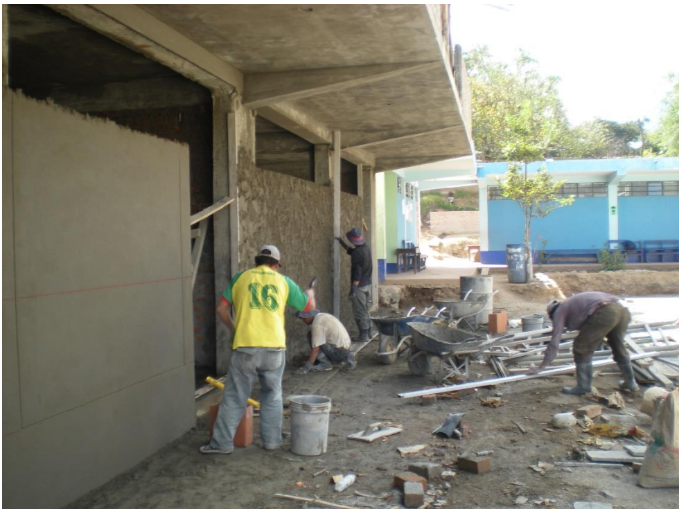
TRABAJO DE TARRAJEO DE MUROS EXTERIORES SE OBSERVA EL DESORDEN Y LA SUCIEDAD DONDE TRABAJAN LOS OPERARIOS FALTA DE USO DE EPPS.
