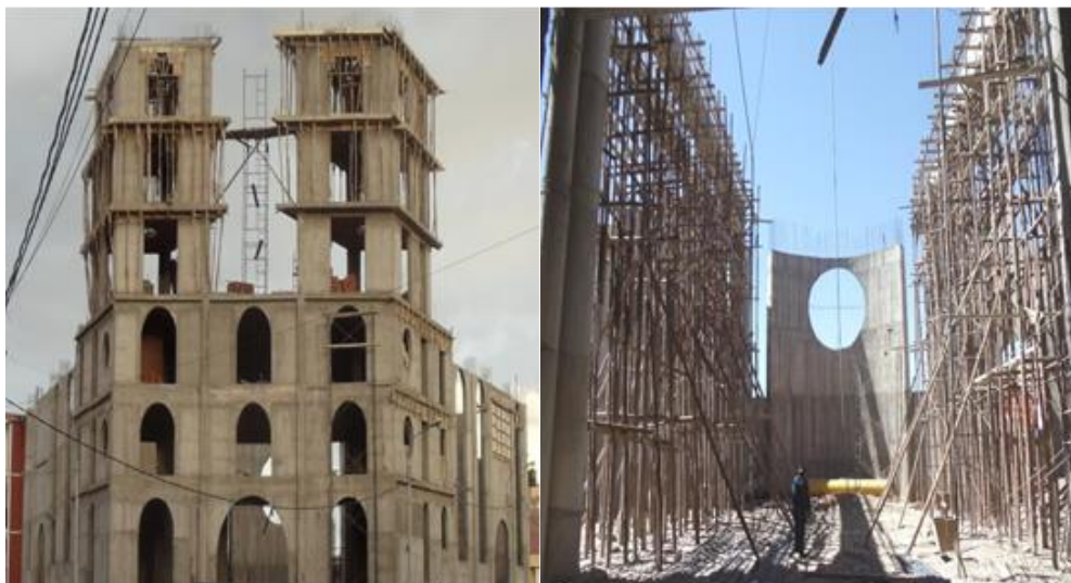
Imagen N° 11: Encofrado de la Iglesia Nuestra Señora de la Merced – Puno - 2013.
