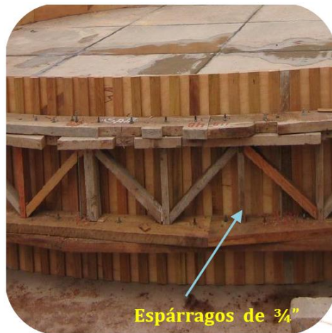
Imagen N° 28: Estructura panel exterior
