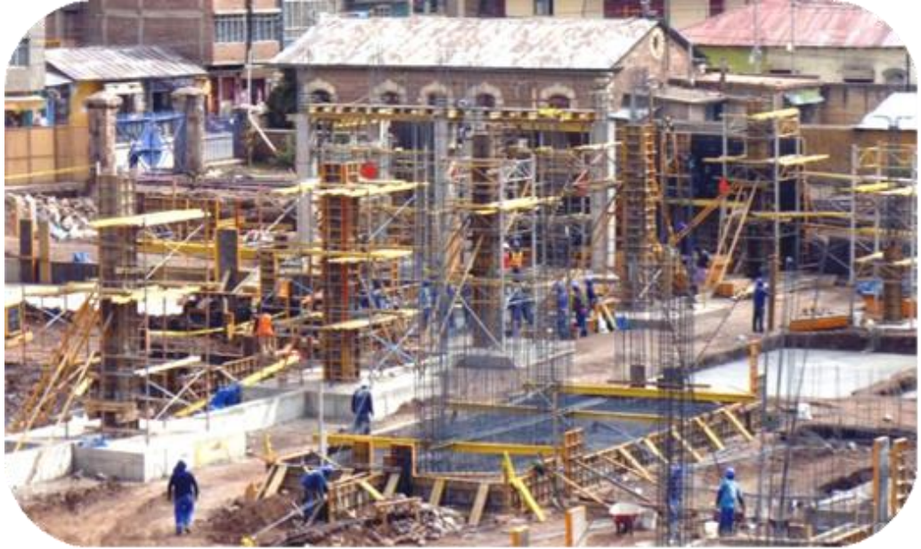
Imagen N° 13: Encofrado metálico, súper mercado Plaza Vea – Puno – 2011.
