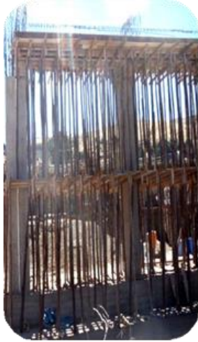
Imagen N° 7: Encofrado de Madera
