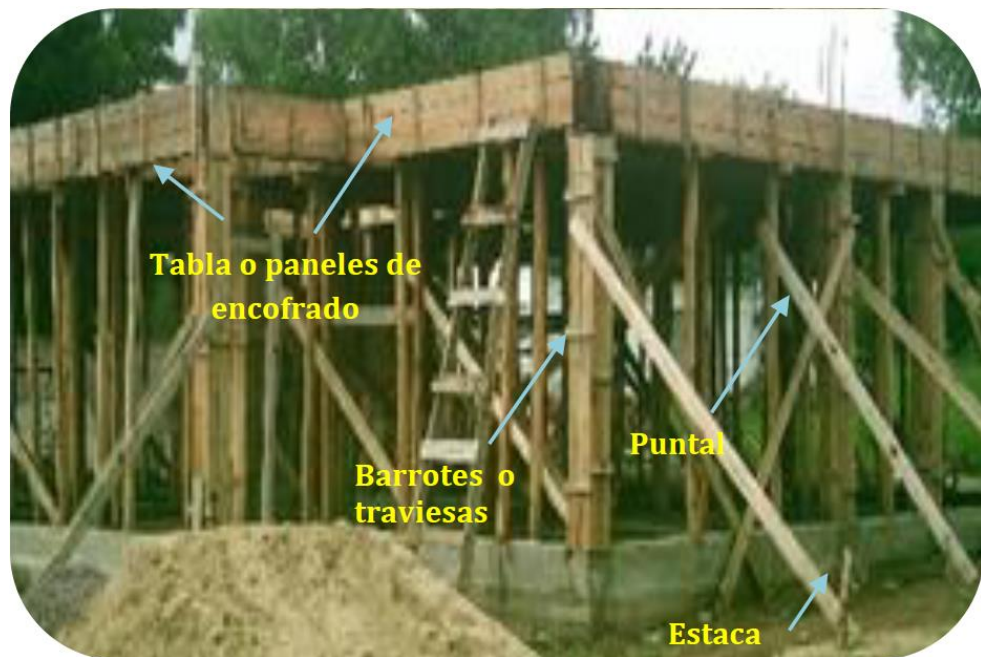
Imagen Nº 12: Partes del Encofrado de Madera
