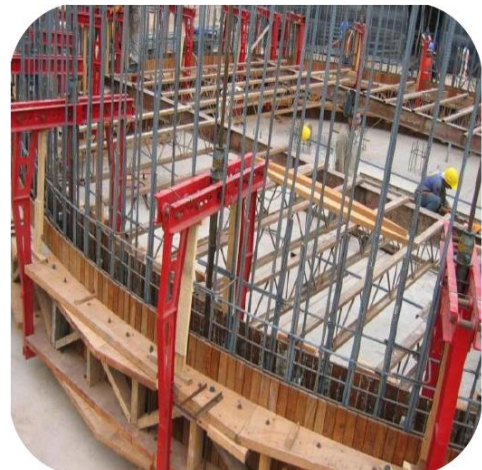
Imagen N° 31: Estructura de la plataforma
