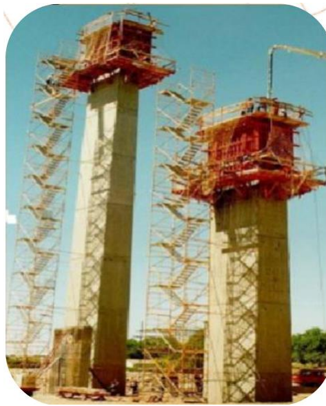
Imagen N° 42: Escaleras de acceso
