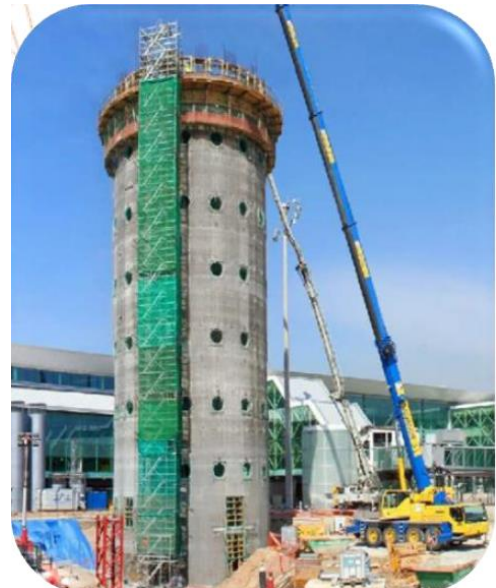
Imagen N° 43: Elevación del concreto
