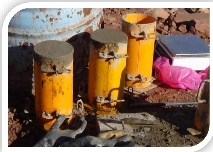
FOTOGRAFIA N° 13: SE OBSERVA EL ENRASADO Y ACABADO.
